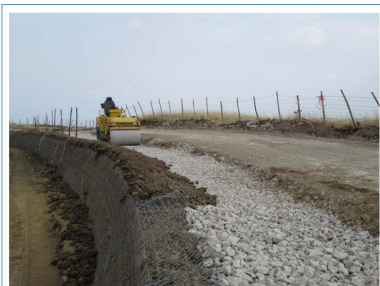
*Fig. 15 - Esempio di opera in terre rinforzate - Fonte HE*
