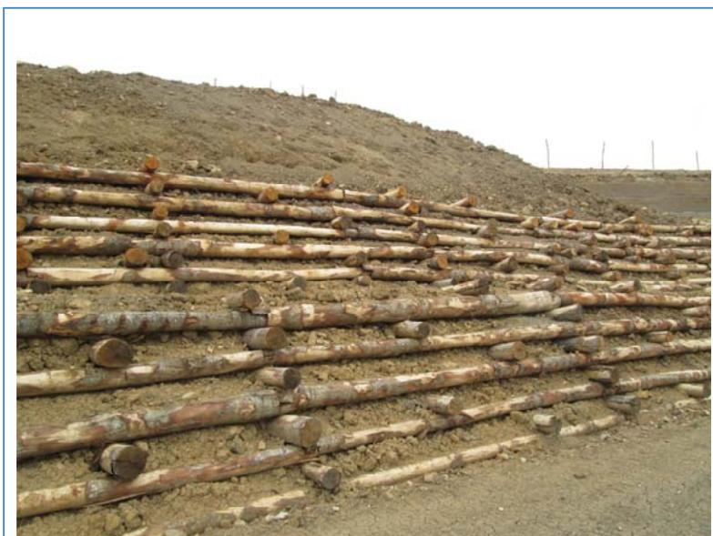
*Fig. 14 - Esempio di opera in palificate in legname - Fonte HE*
