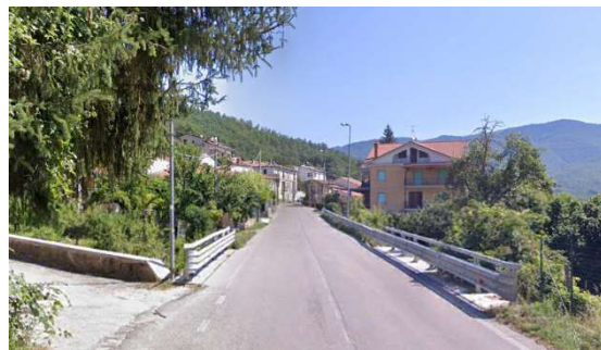
Fig.10 – SS.260 – Cavagnano Fraz. di Montereale
