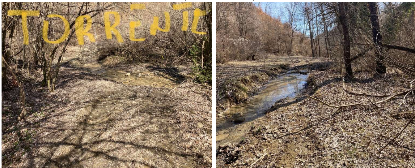
Figura 21 - il Fosso Mondragone in corrispondenza della pkm di progetto 4+100
