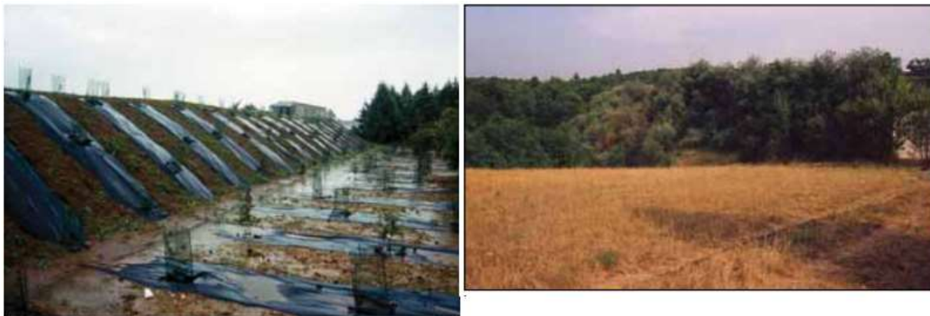
Figura 22 - Consolidamento scarpate: messa a dimora di specie arbustive e arboree con reti antifauna e pacciamatura a strisce
