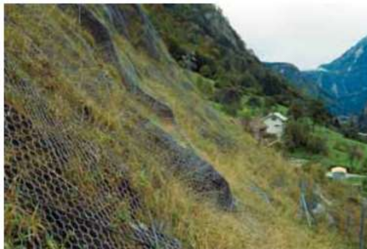
Figura 24 - Rivestimento vegetativo in geostuoia tridimensionale e rete inerbita
