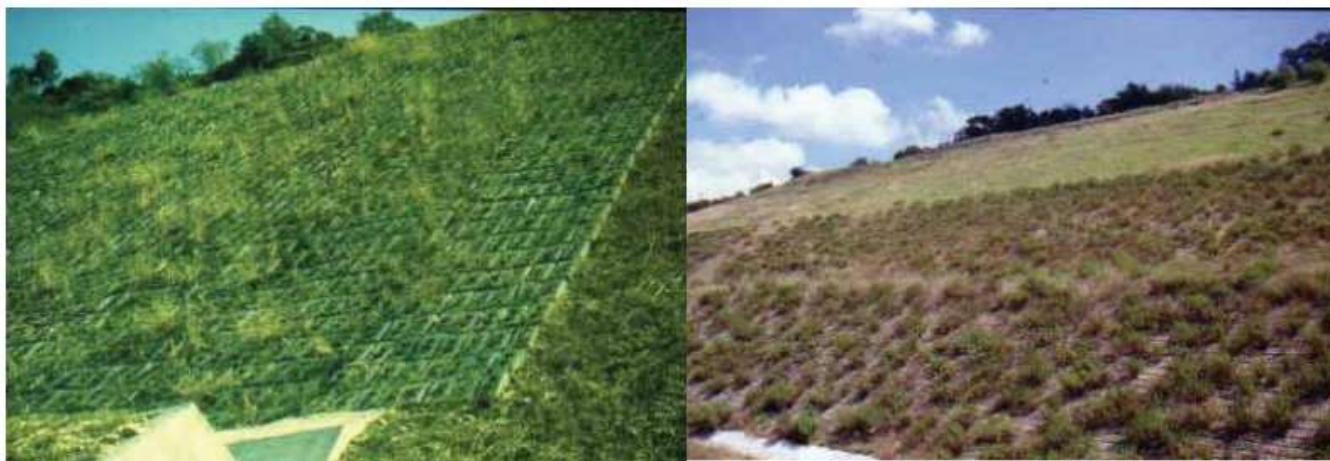
Figura 23 - Scarpate stabilizzate con mattonelle in cls poggiate su geotessili e rivegetate.
