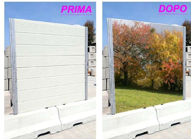
Figura 82 - mitigazione ambientale: recinzione di cantiere
