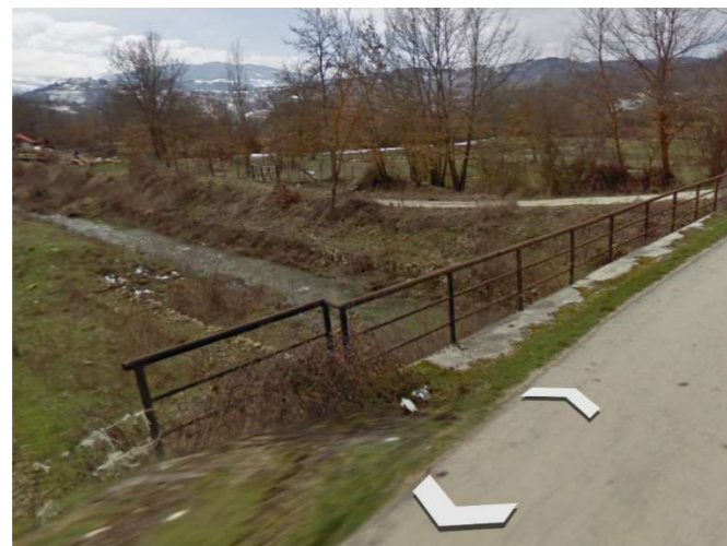
Figura 68 - attraversamento 2 - vista lato SX
