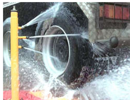
Figura 83 - Interventi di mitigazione delle polveri
