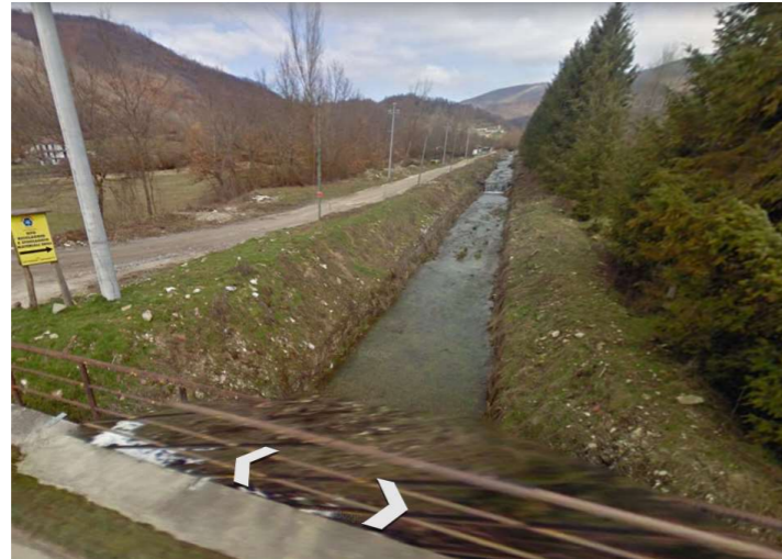
Figura 67 - attraversamento 2 - vista lato DX
