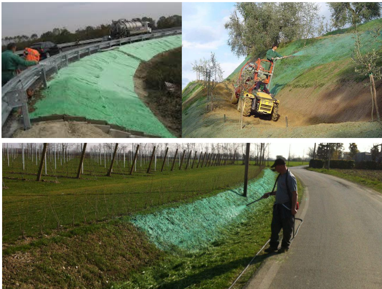
Figura 27 – Tecniche di idrosemina
