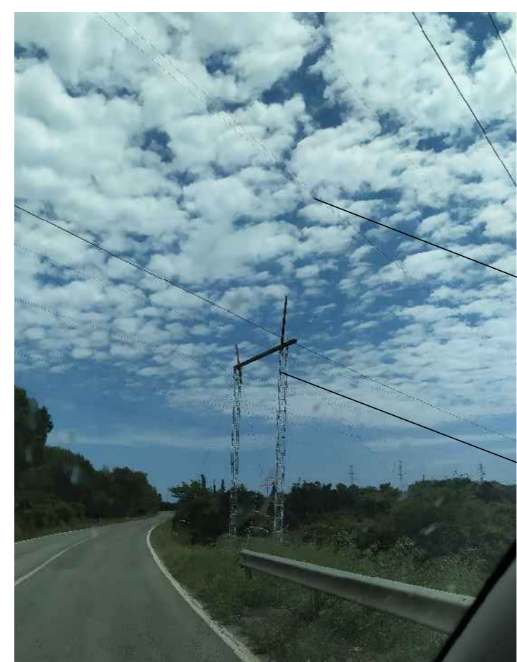
Cavi elettrici Cavalletto per sollevamento cavi elettrici
