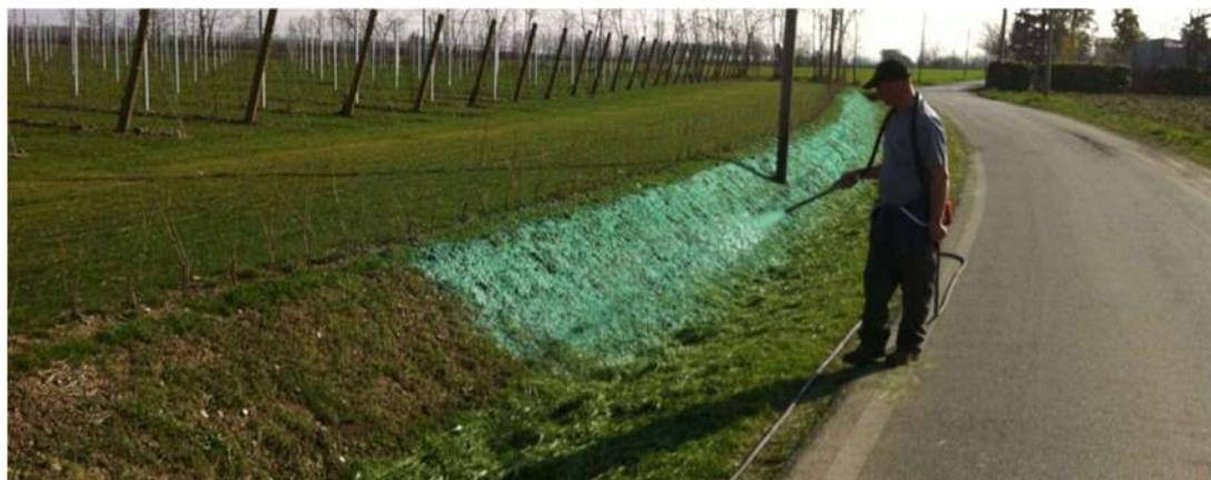
*Figura 55 - Sistema di idrosemina*
