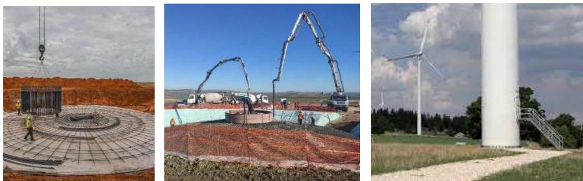
Figure 35 - Immagini tipo di alcune fasi di lavorazione della Fondazione degli aerogeneratori
