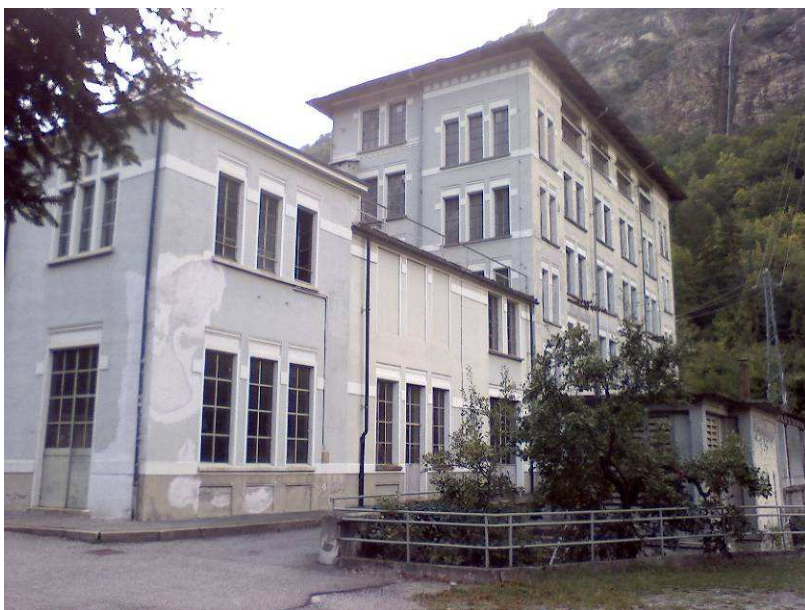
Figura 40 – dettagli delle finestre della centrale di Chiomonte riproposto nel nuovo fabbricato centrale
