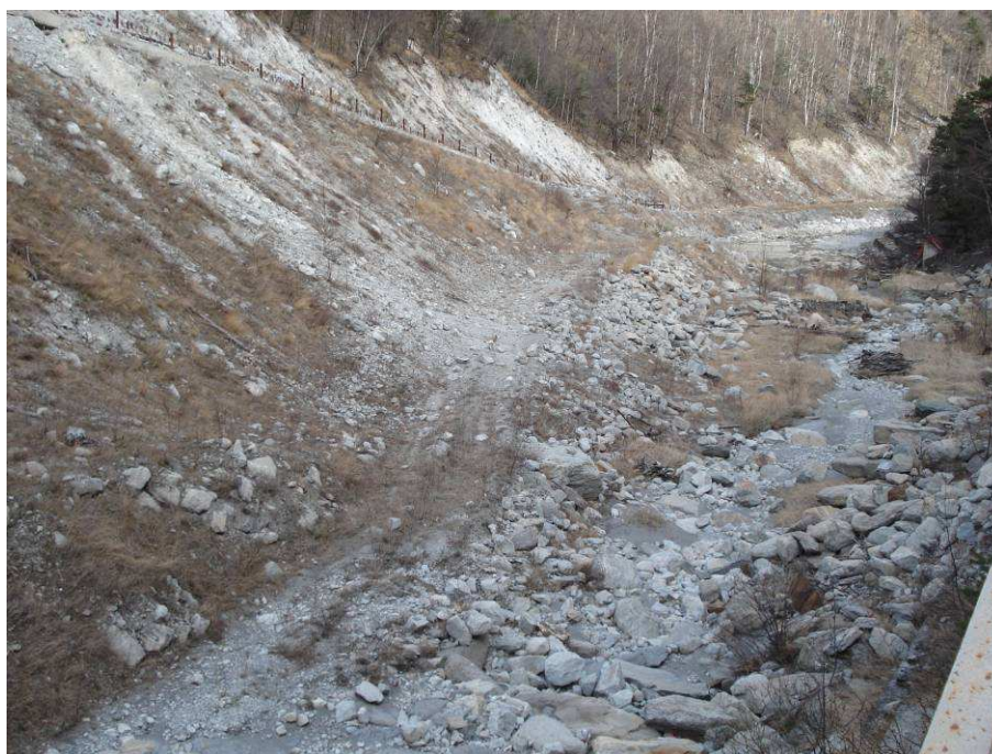
Figura 29 – tratto di viabilità di cantiere per accedere al canale di derivazione per l'esecuzione dei lavori
