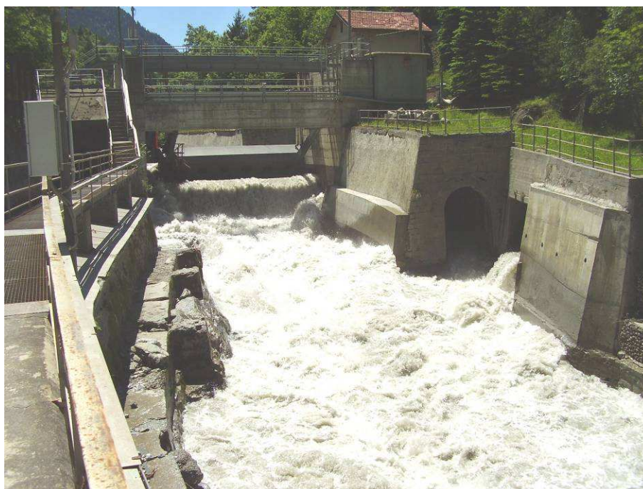
Figura 24 – Traversa di derivazione il loc. Serre la Voute e tratto iniziale del canale in sponda destra oggetto di riqualificazione
