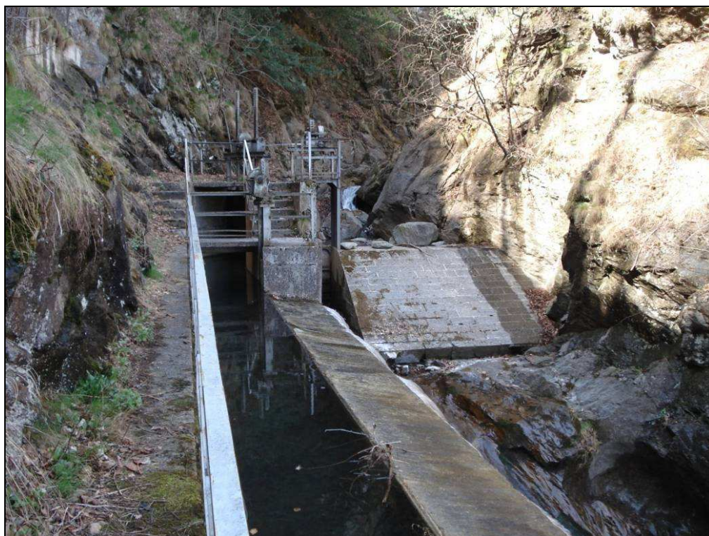
Figura 31 – zona di intervento sulla presa del rio Galambra
