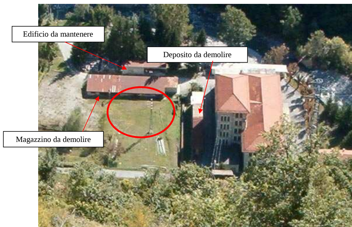
Figura 37 - Panoramica dell'area in cui sarà realizzata la nuova centrale. È visibile l'attuale centrale da dismettere e l'attiguo prato in cui sorgerà la nuova struttura
