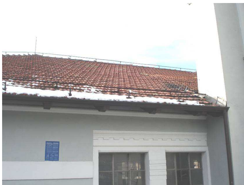
Figura 38 – dettagli della copertura della centrale di Chiomonte riproposti nel nuovo fabbricato centrale
