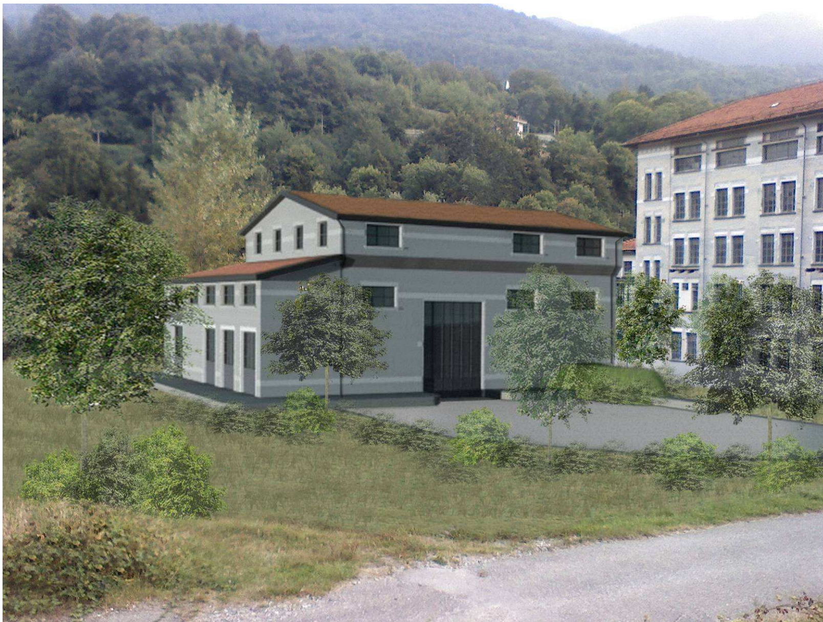
Figura 63 – area Centrale di Chiomonte – nuova centrale con vista da strada per Giaglione
