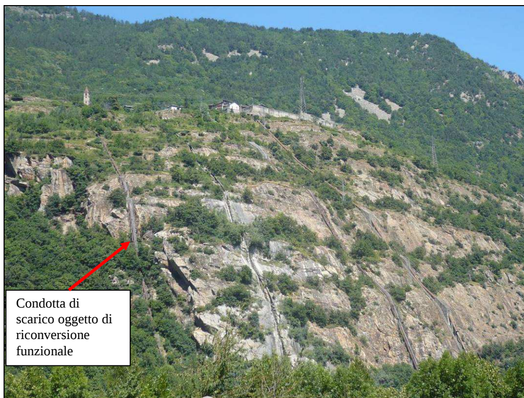
Figura 36 - Panoramica delle condotte poste su versante
