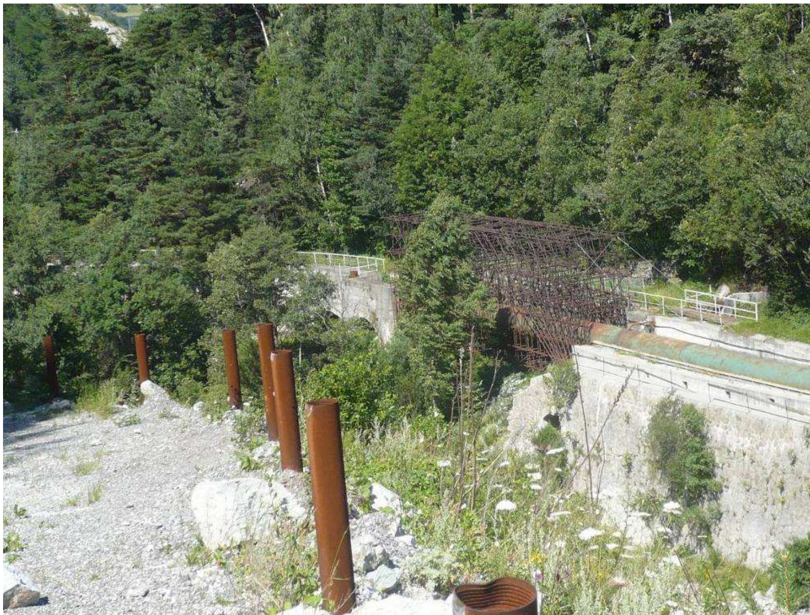
Figura 52 – Serre La Voute: tubazione metallica e ponteggio esistenti
