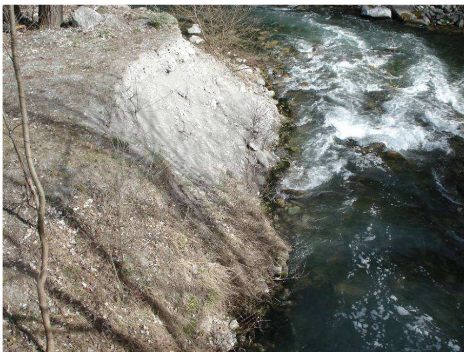
Figura 43 – scarico delle portate turbinate dalla centrale di Chiomonte nell'alveo della Dora Riparia in sponda sinistra idrografica
