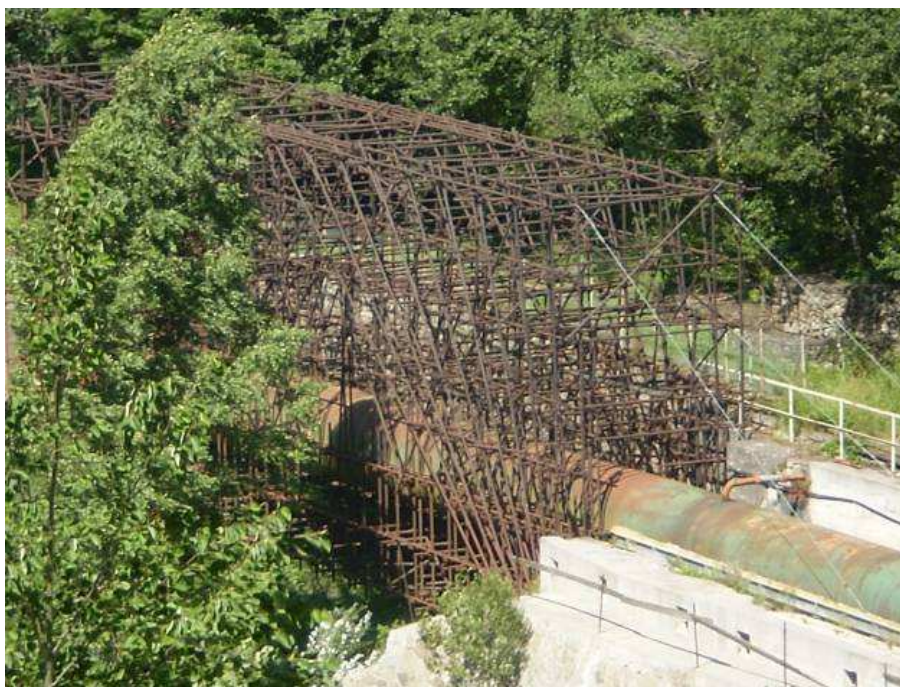
Figura 26 - Struttura di sostegno in tubolari di tipo "Innocenti" in corrispondenza dell'esistente pontetubo oggetto di intervento
