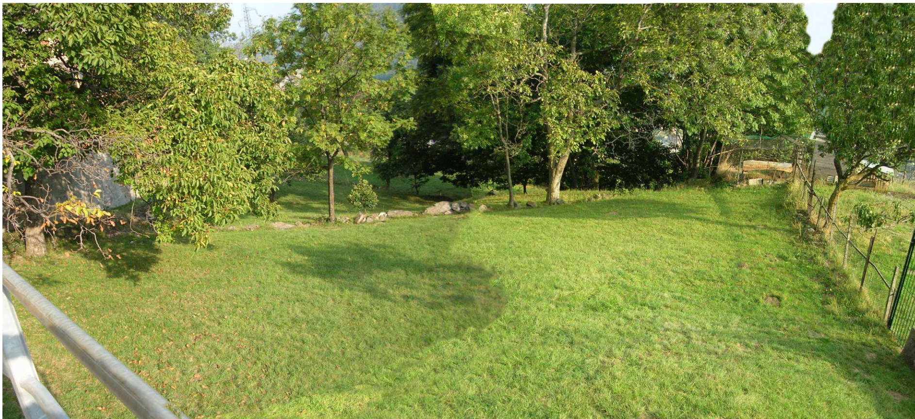
Figura 58 – versante a valle dal piazzale della Chiesa di S.Andrea in loc. Ramat – stato di fatto
