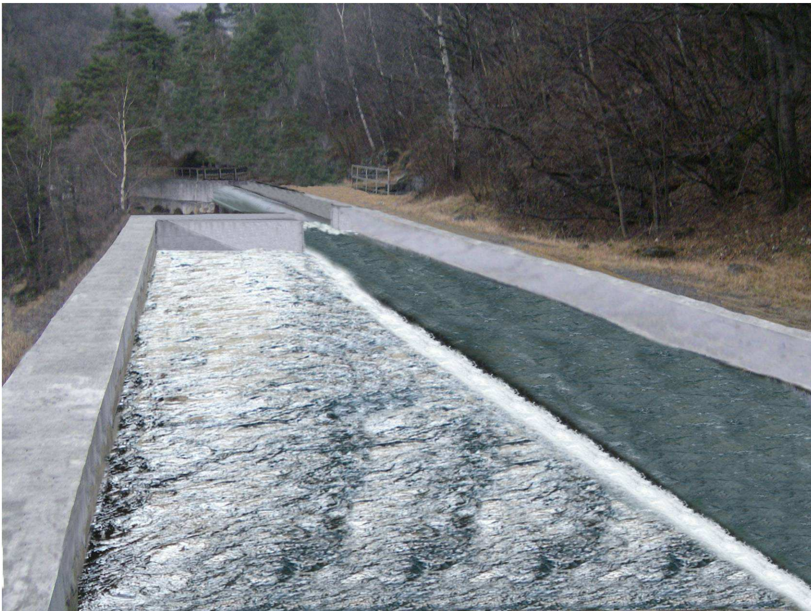
Figura 55 – nuovo dissabbiatore e nuovo canale di gronda con posa nuova tubazione autoportante
