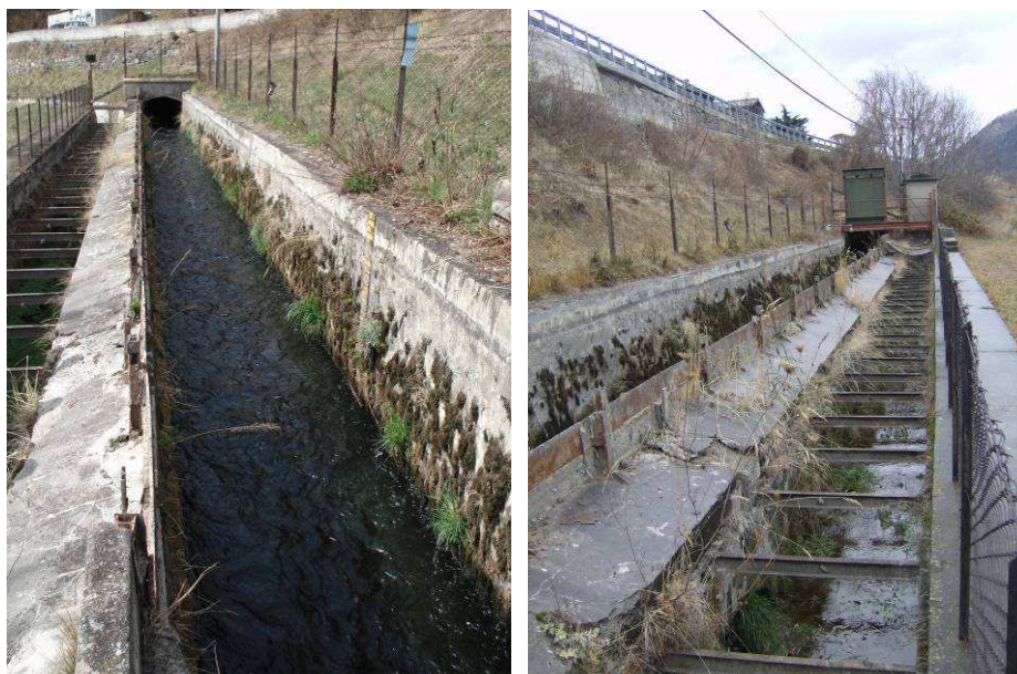
Figura 30 – manufatto sfioratore Pontet oggetto di riqualificazione strutturale e funzionale
