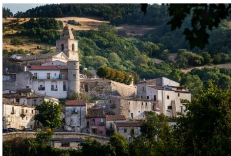
Figura 19 - Centro abitato - Comune di Alberona
