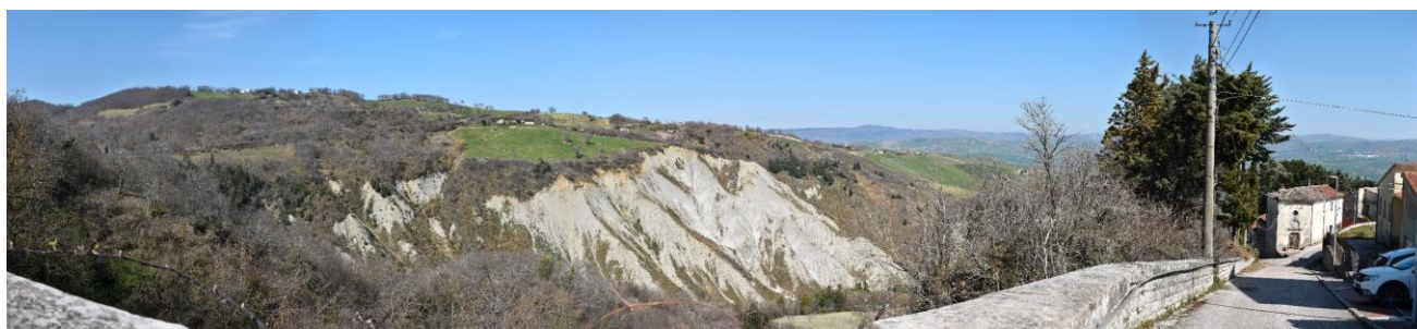
Stato di fatto del F186
