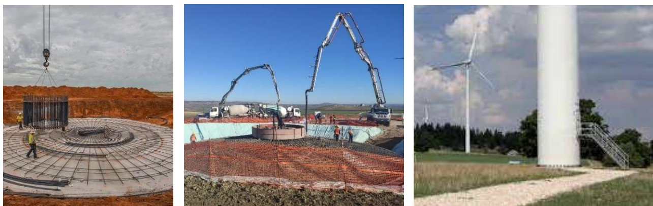
Figure 14 - Immagini tipo di alcune fasi di lavorazione della Fondazione degli aerogeneratori
