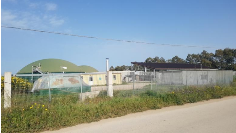
Figura 17: Vista su impianto a biomassa.
