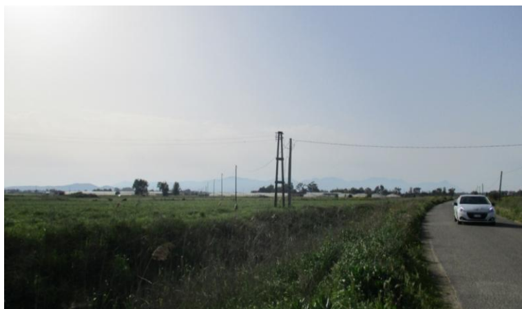
Figura 16: Vista su impianti serricoli.
