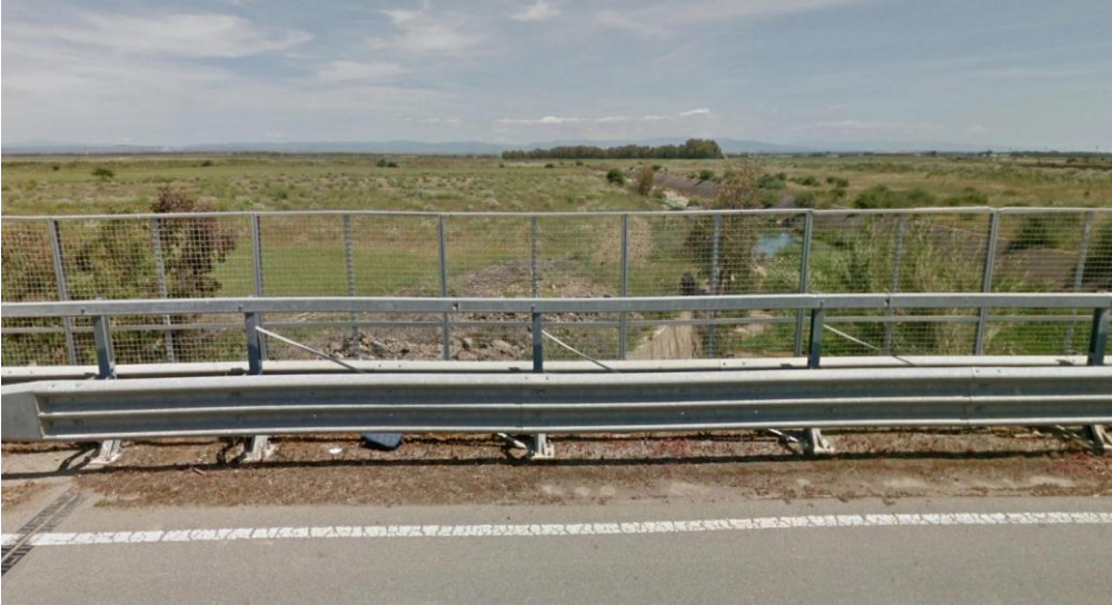
Figura 31: Vista situazione attuale da Punto Bersaglio B sul ponte della SP 3.
