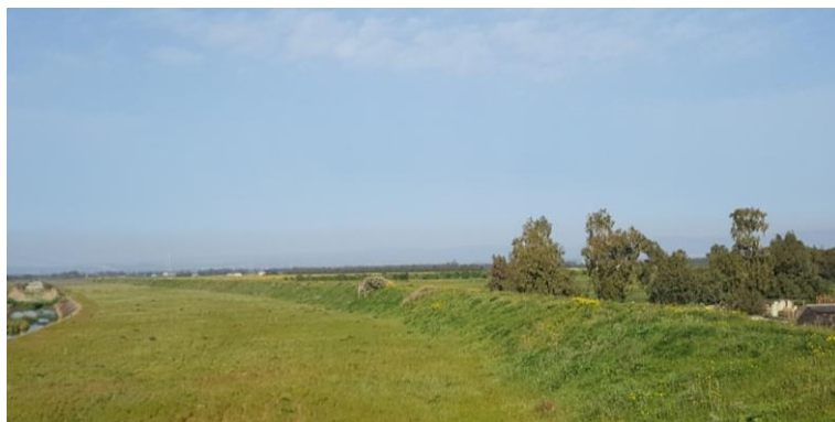
Figura 20: Vista sul sito di intervento dal ponte sul canale Riu Nou.
