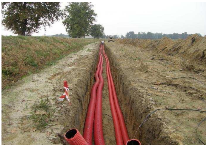
Figura 15: Scavo tipo per posa cavidotto.
