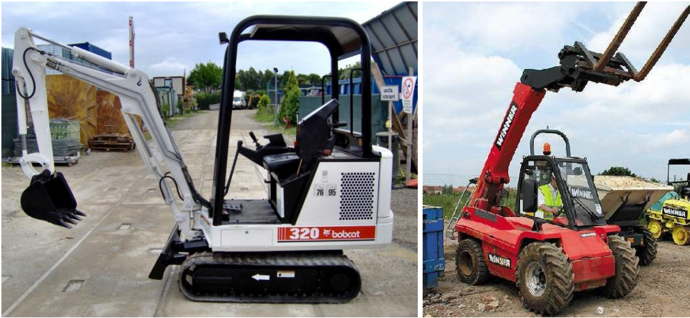
Figura 8 Esempi di macchine operatrici impegnate per la costruzione dell'impianto (Bobcat e Manitou).
