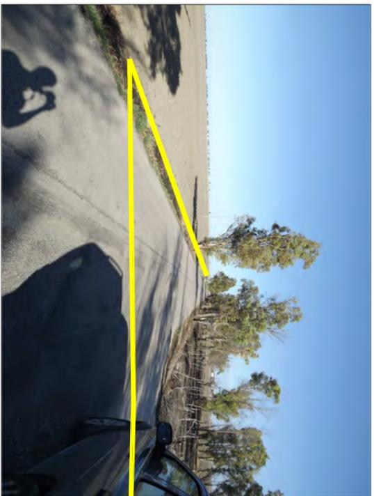
Foto 42 - Il tracciato del cavidotto, in prossimità della strada di accesso alla stazione Tema, attraverserà in trasversale la SP70 (con scavo a sezione ristretta). L'ultimo tratto del cavidotto seguirà la strada di accesso alla stazione.
