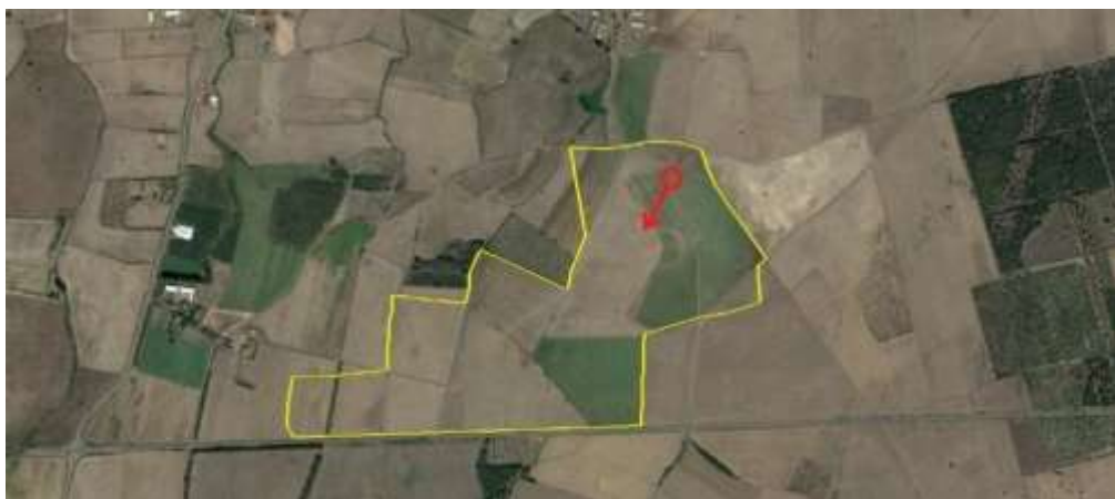
Fig. X-X: Area dei lavori, nel cerchio rosso il punto di scatto, nella freccia rossa la direzione
