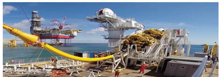
Figura 22 - Particolare dell'imbarcazione posa cavi - NKT Cables
