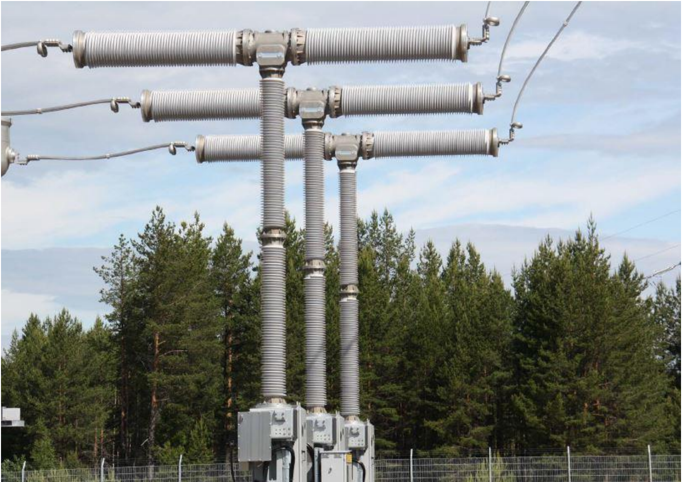
Figura 29 - interruttore 420kV (fonte Siemens)
