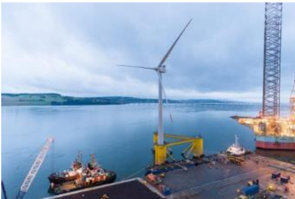
Figura 2-24 – Assemblaggio piattaforma galleggiante (Fonte: kinkardine - Cobra)
