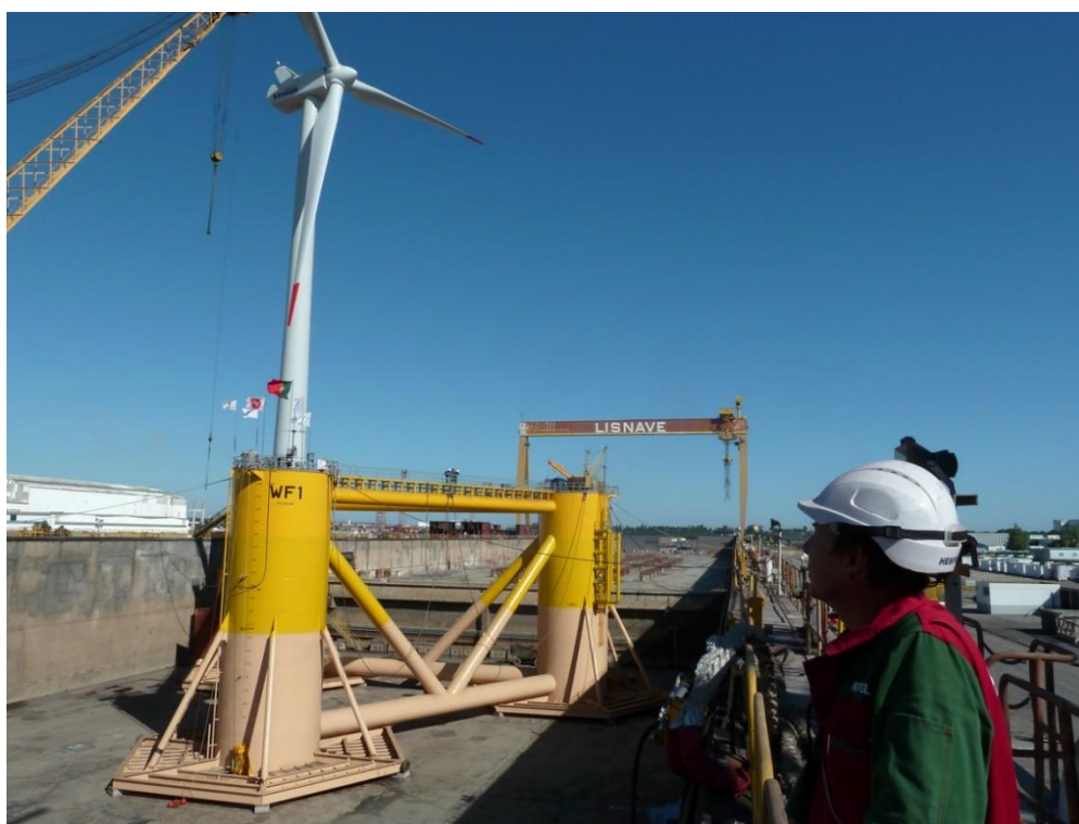
Figura 2-25 – Fasi di assemblaggio della piattaforma galleggiante (Fonte: Windfloat Atlantic Project)
