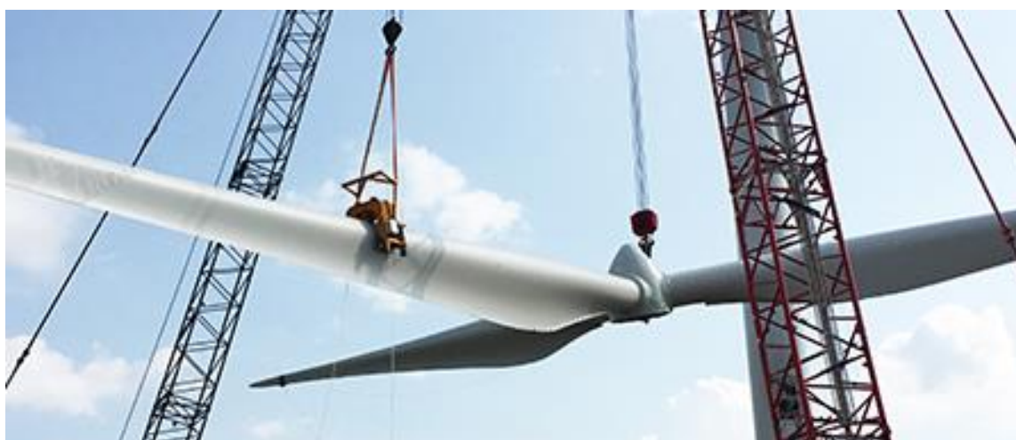
Figura 2-27 – Sollevamento del rotore (Fonte: Elronic Wind solution)
