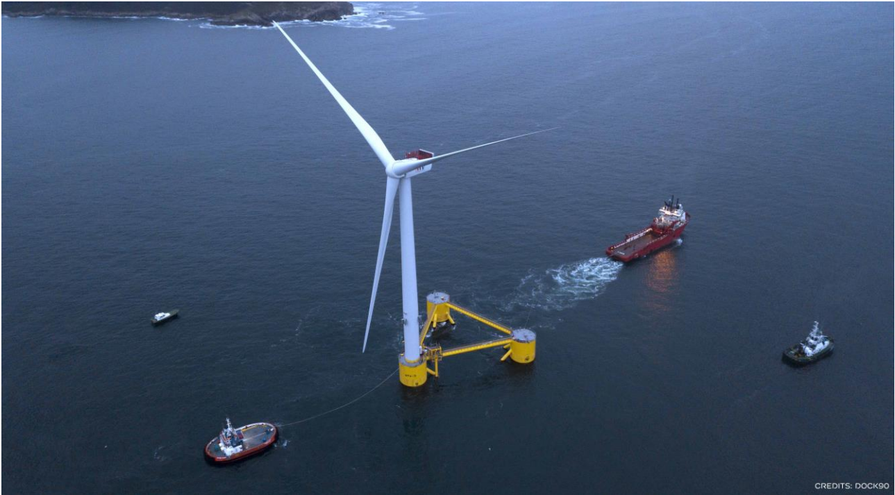
Figura 2-28 – Esempio dell’operazione di rimorchio (Fonte Windfloat Atlantic Project)
