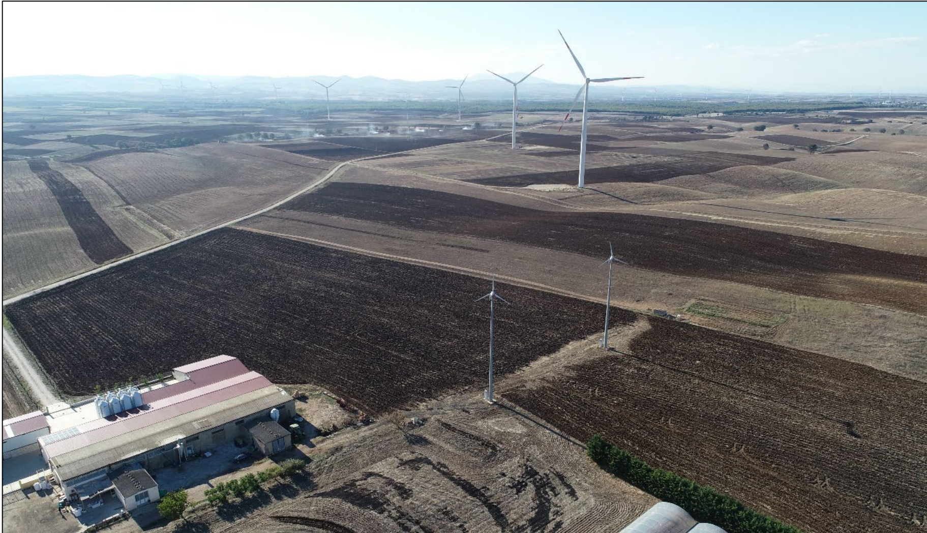
Figura 40 - Area d'installazione impianto
