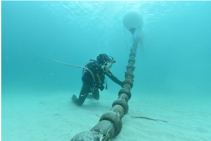
Figura 2.15: Esempio di metodo di posa con gusci di protezione (Fonte: Farinia Group)
