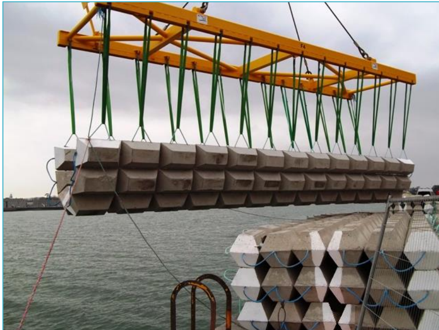
Figura 2.13: Protezione di un cavo sottomarino con cubicoli (Fonte: Subsea Protection Systems Ltd)
