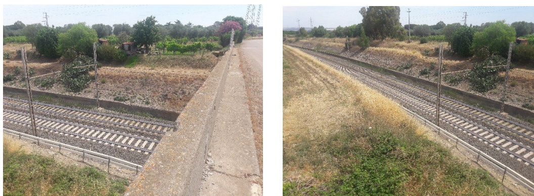
Figura 4:18: Attraversamento linea ferroviaria
