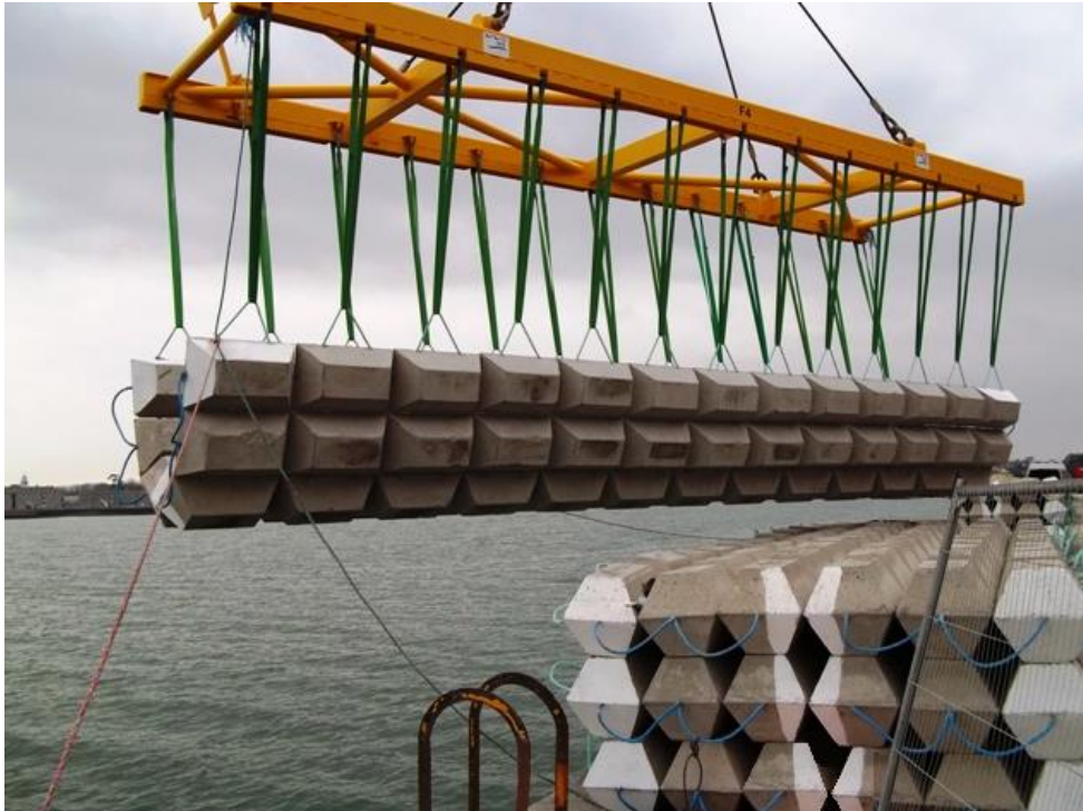
Figura 4.19: Protezione di un cavo sottomarino con cubicoli (Fonte: Subsea Protection Systems Ltd)
