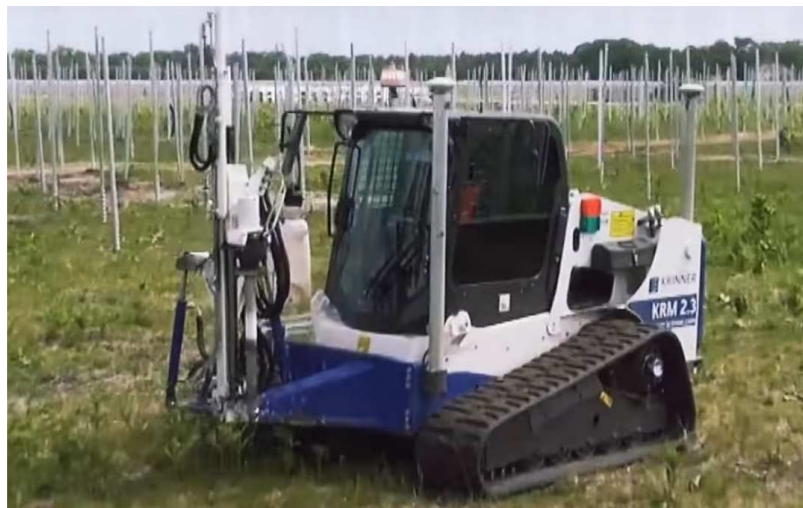
Fig. 15 Esempio di fissaggio delle strutture di supporto
