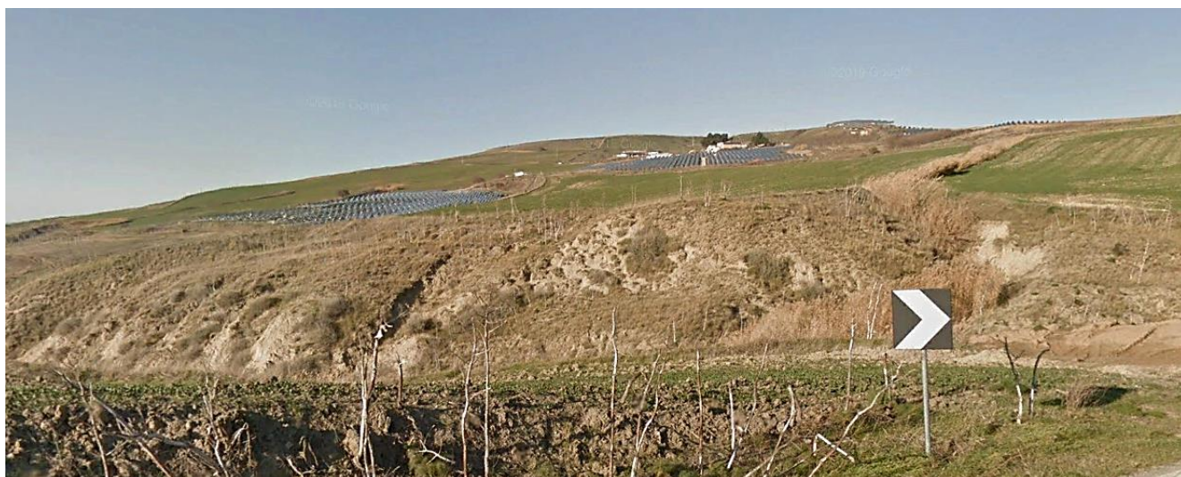
Figura 3-35: Impianti fotovoltaici già realizzati a nord-ovest dell'area di intervento
