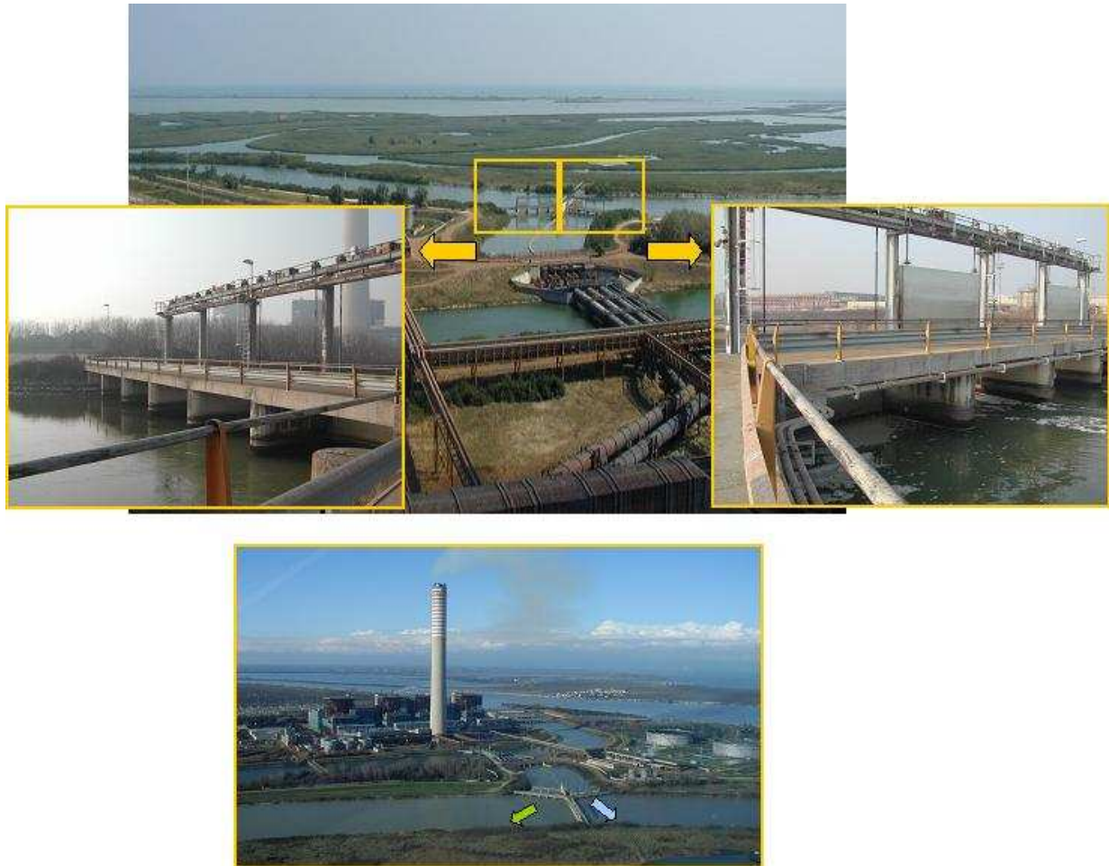
Figura 8 Dettagli delle opere di scarico della centrale. In alto : vista dalla centrale con dettaglio delle paratoie che convogliano lo scarico verso il fiume Po (a sinistra) e verso il canale di scarico a mare (a destra). In basso : vista verso la centrale con indicazione della direzione di scarico a mare (freccia verde) e a fiume (freccia azzurra)
