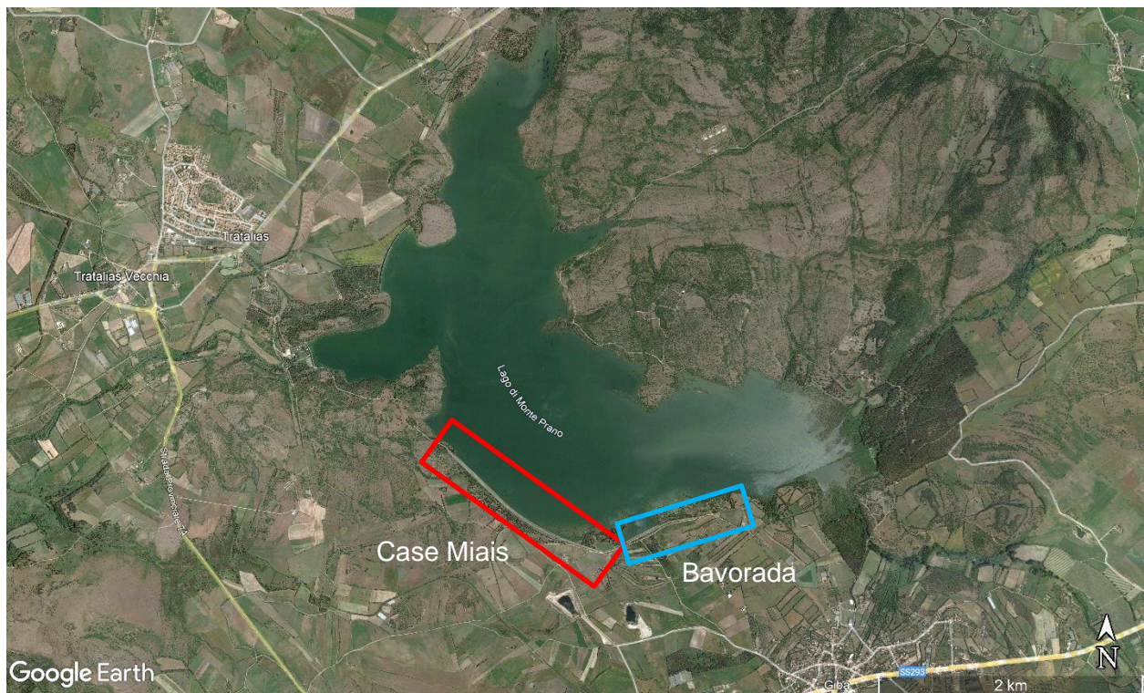
Figura 3.1 Ubicazione dell'area degli interventi sulle dighe in terra su foto satellitare (Google Earth, 2022)
