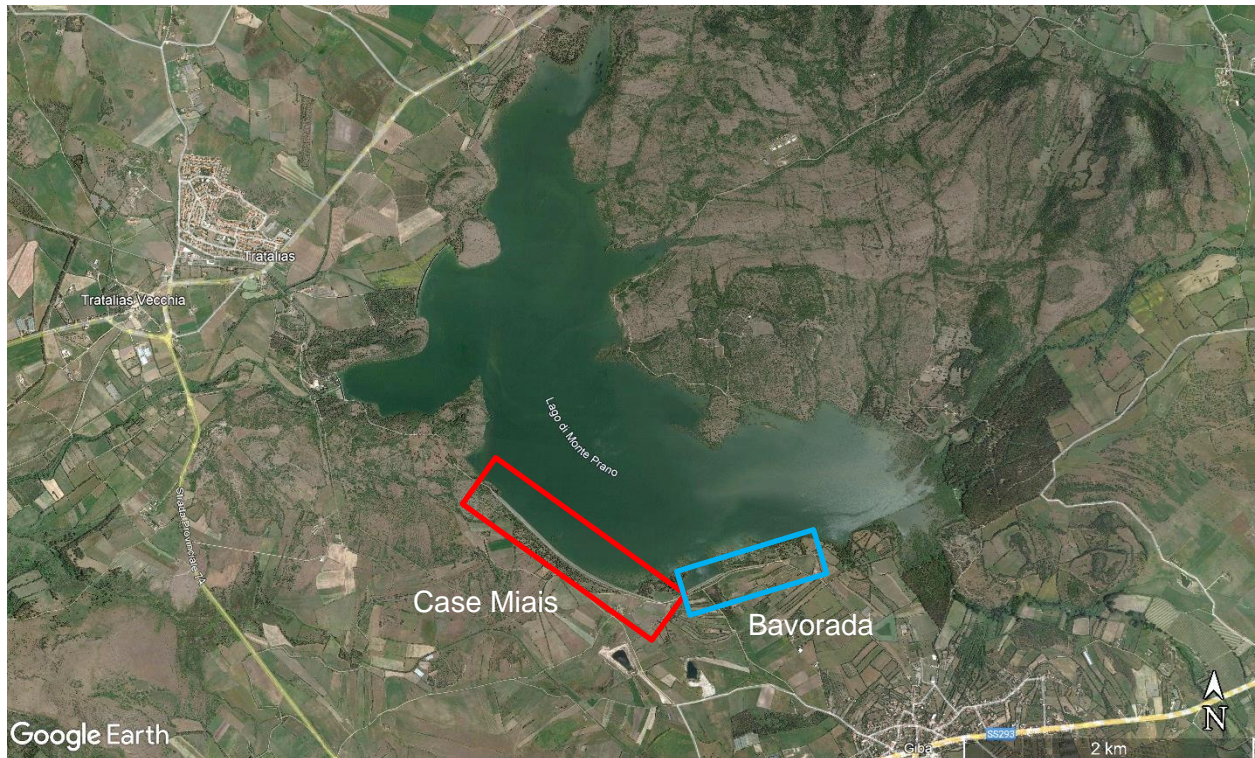
Figura 1-1 Ubicazione dell'area degli interventi sulle dighe in terra su foto satellitare (Google Earth, 2022)
