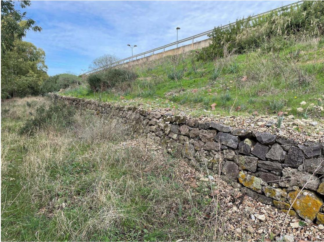
*Figura 9.16 IMG\_5833 - Diga Case Miais muro a secco presso il piede del paramento di valle*
