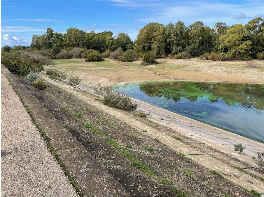
*Figura 9.10 IMG\_5806 - Diga Bavorada paramento di monte*
