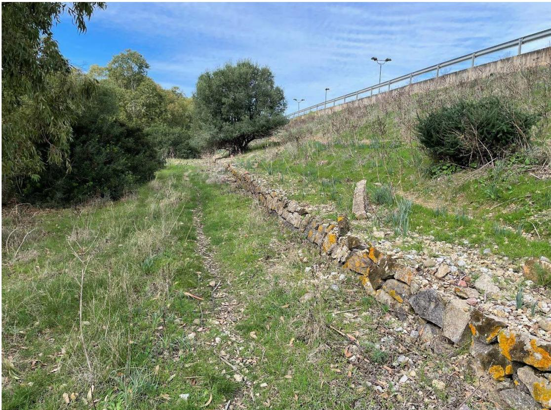
*Figura 9.15 IMG\_5827 - Diga Case Miais muro a secco presso il piede del paramento di valle*
