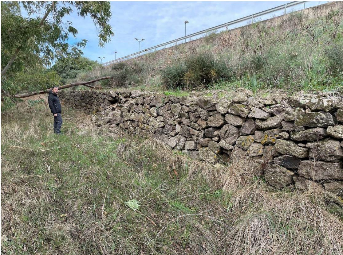
*Figura 9.19 IMG\_5844 - Diga Case Miais muro a secco presso il piede del paramento di valle*
