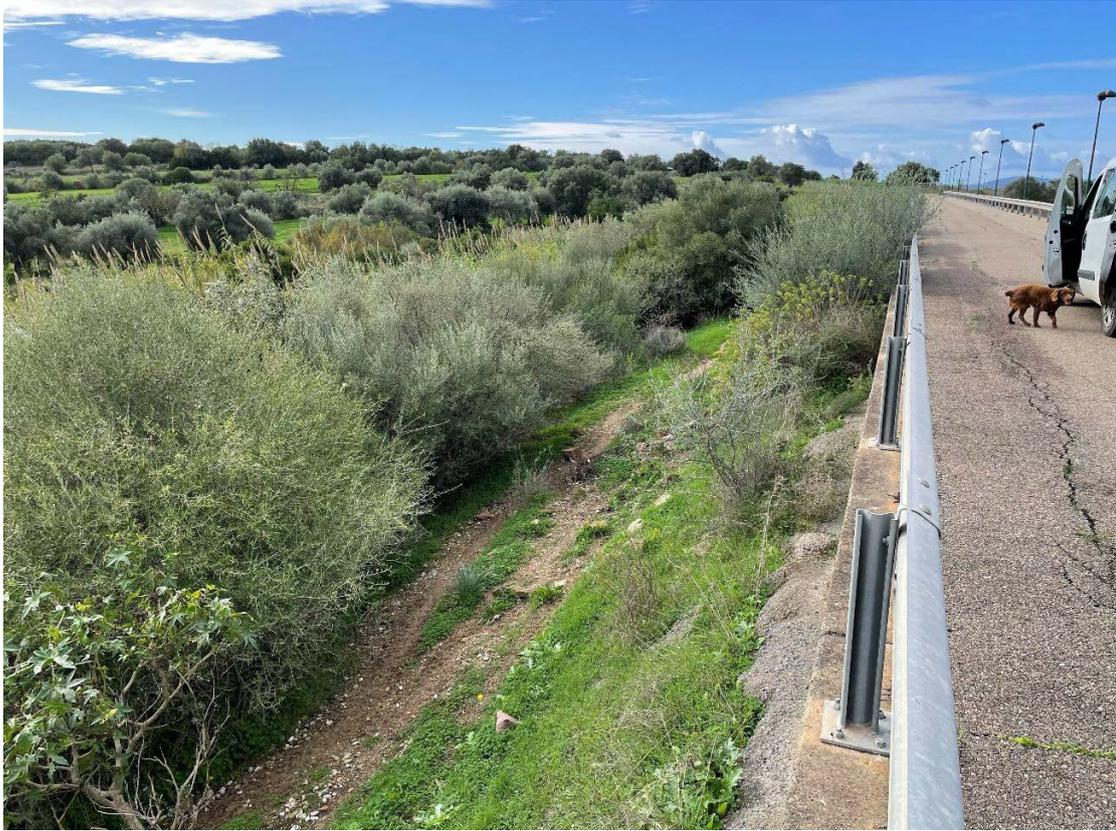
*Figura 9.12 IMG\_5808 - Diga Bavorada paramento di valle , si notano fessurazioni longitudinali dell'asfalto sul coronamento della diga*
