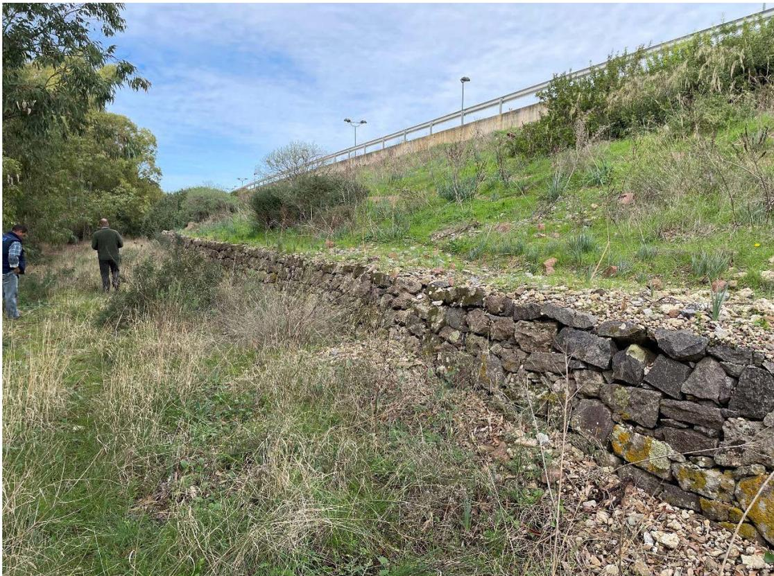
*Figura 9.17 IMG\_5835 - Diga Case Miais muro a secco presso il piede del paramento di valle*
