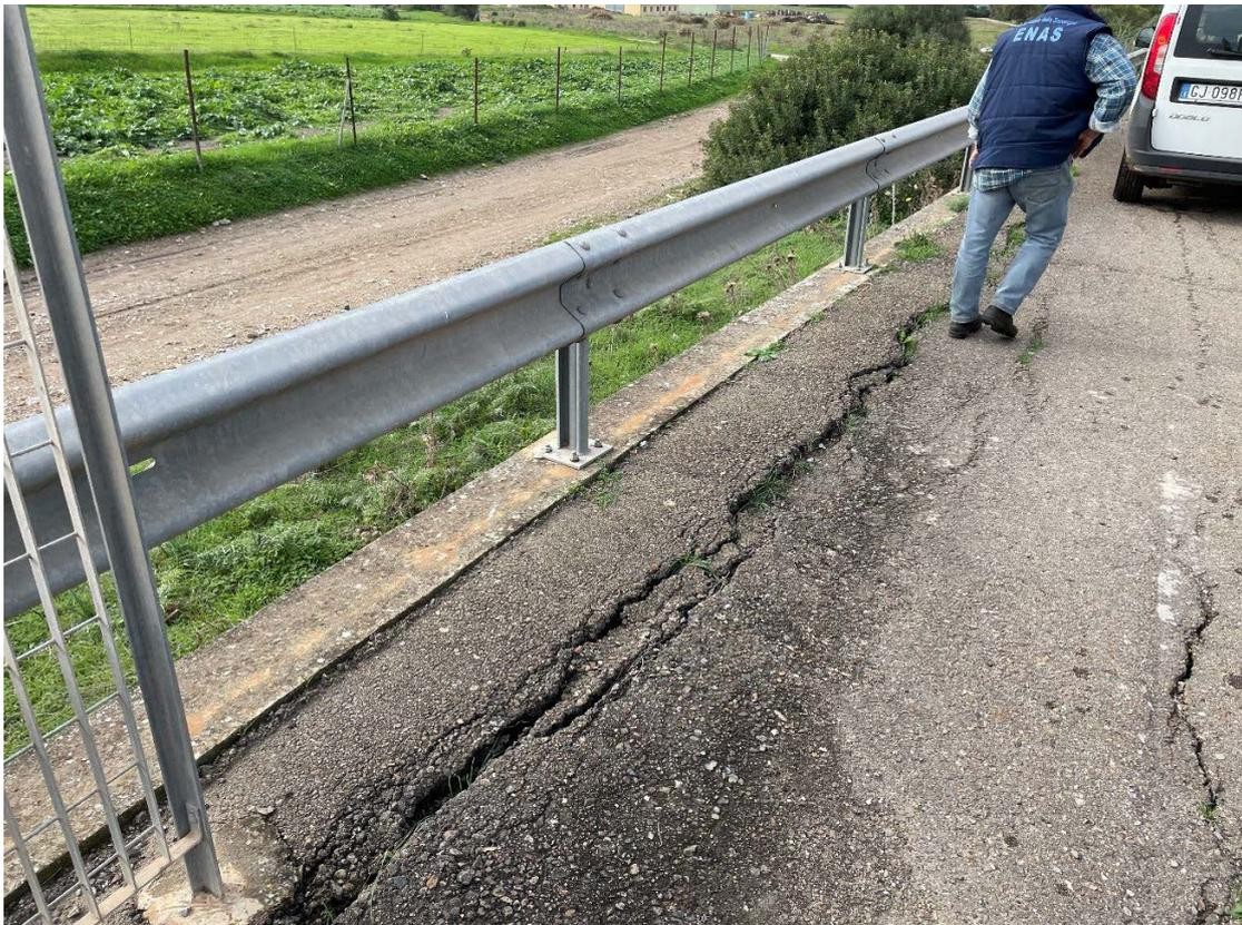
Figura 9.21 IMG\_5849 - Fessurazioni longitudinali dell'asfalto sul coronamento presso la Diga Case Miais
