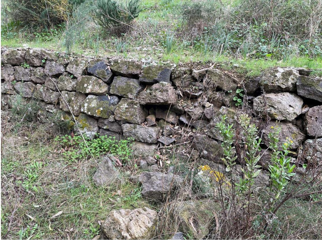
*Figura 9.18 IMG\_5840 - Diga Case Miais muro a secco parzialmente danneggiato presso il piede del paramento di valle*
