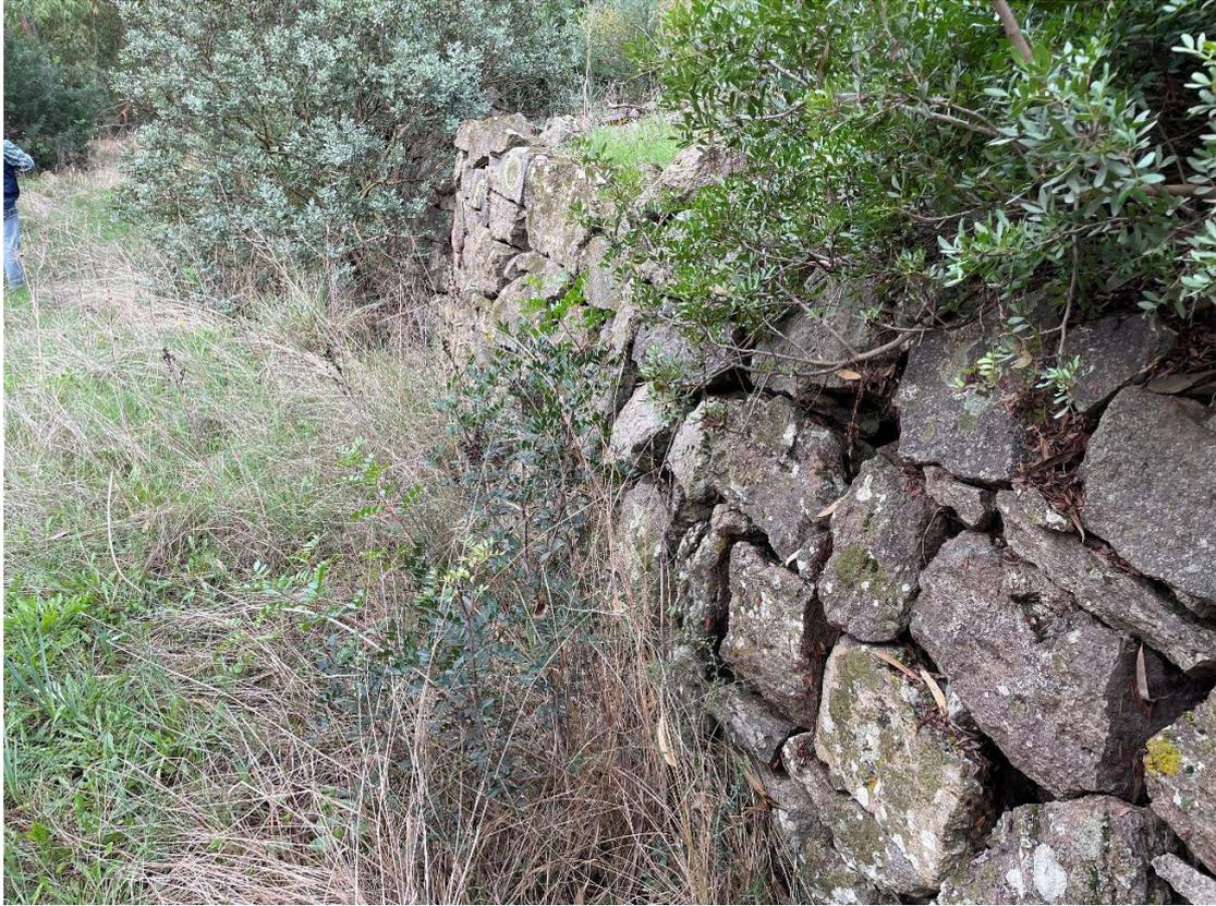
Figura 9.20 IMG\_5845 - Diga Case Miaismuro a secco presso il piede del paramento di valle
