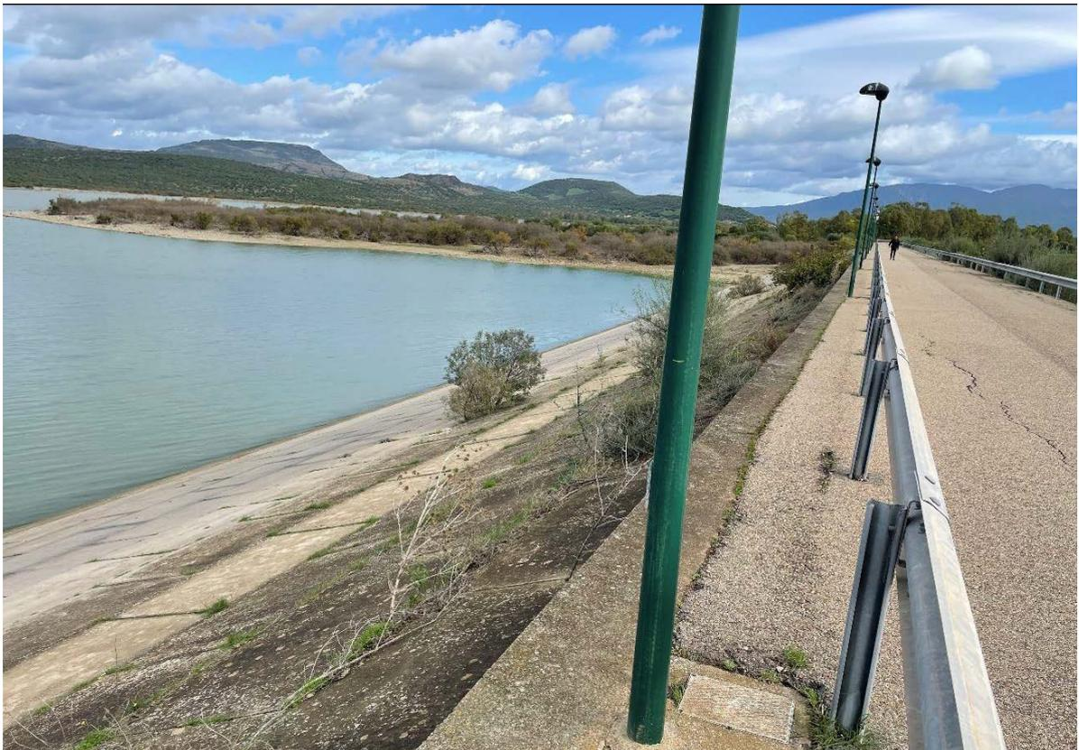
*Figura 9.11 IMG\_5807 - Diga Bavorada paramento di monte, si notano fessurazioni longitudinali dell'asfalto sul coronamento della diga*
