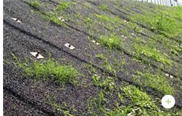
Figura 5.6. Geocomposito antierosivo accoppiato a rete metallica a doppia torsione
