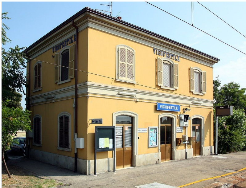
Figura 13.3 - Vista del fabbricato viaggiatori della stazione di Vicofertile
