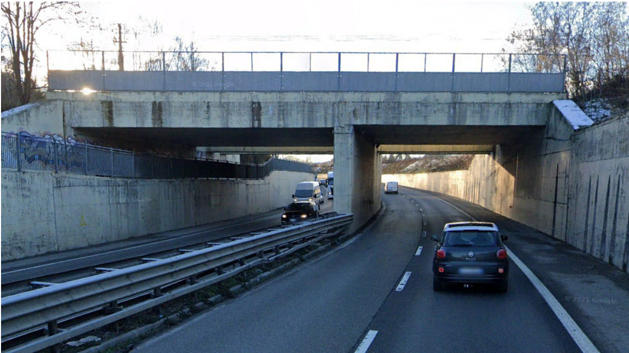
FIGURA 56 VISTA SCATOLARE ESISTENTE
