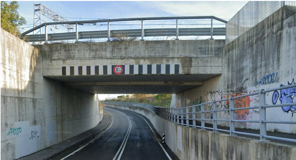
FIGURA 58 VISTA SCATOLARE ESISTENTE
