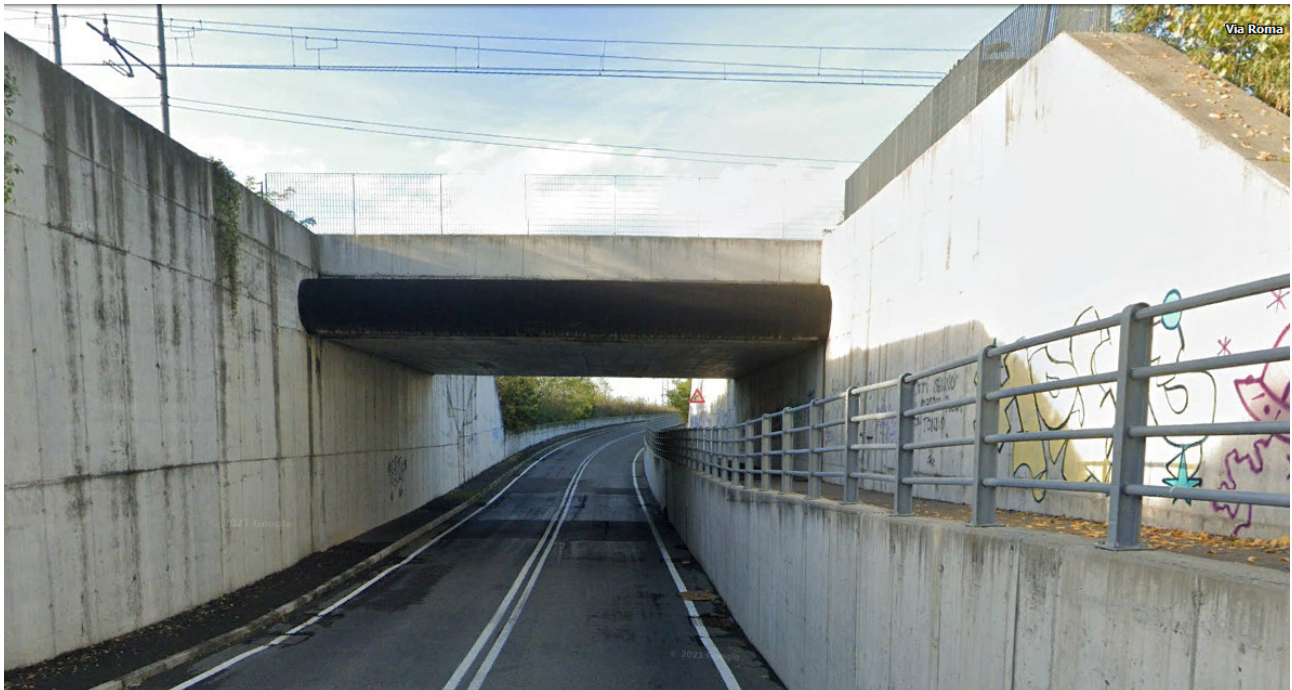
FIGURA 62: VISTA SCATOLARE ESISTENTE
