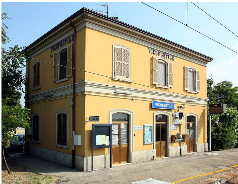
FIGURA 60 VISTA DEL FABBRICATO VIAGGIATORI DELLA STAZIONE DI VICOFERTILE
