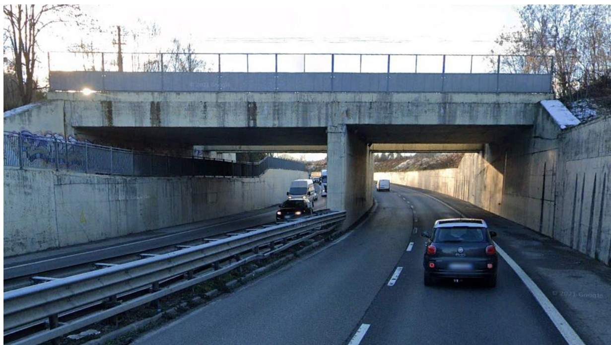
Figura 30: Vista scatolare esistente
