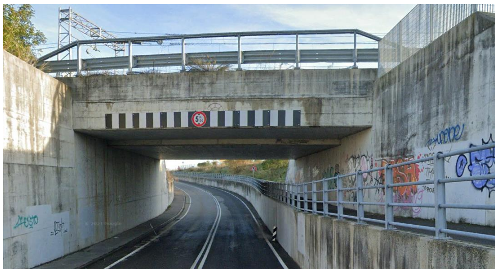
Figura 35: Vista Scatolare Esistente
