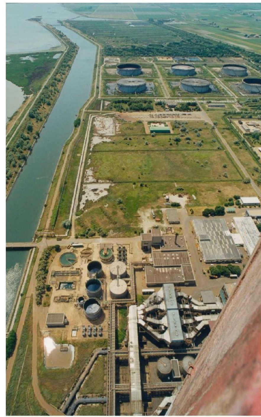
Parco combustibili sud, Edificio demineralizzatore e fabbricati di servizio
