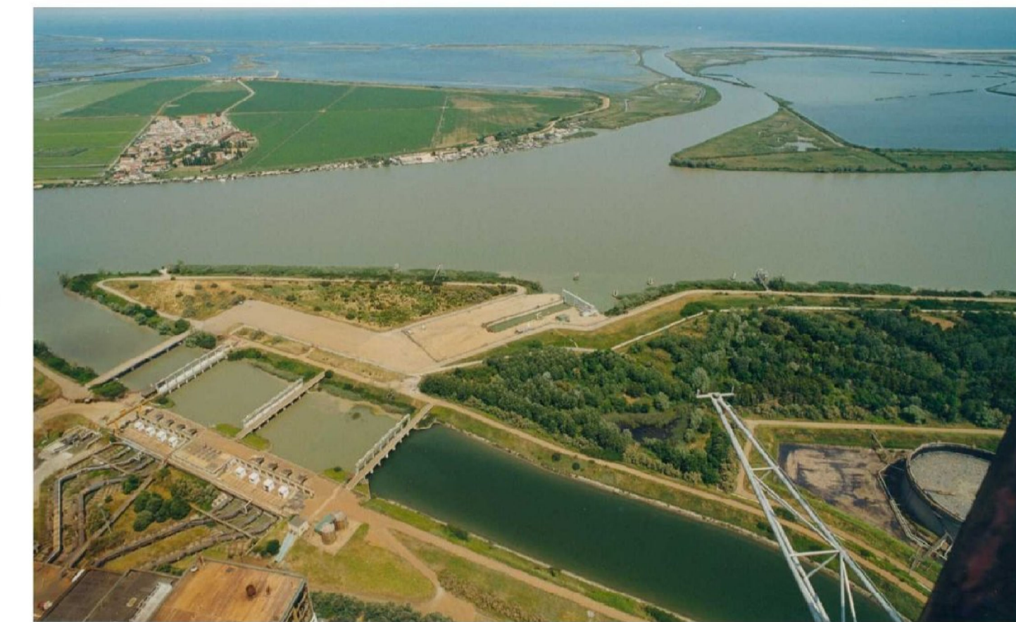
Canale di presa e Darsena
