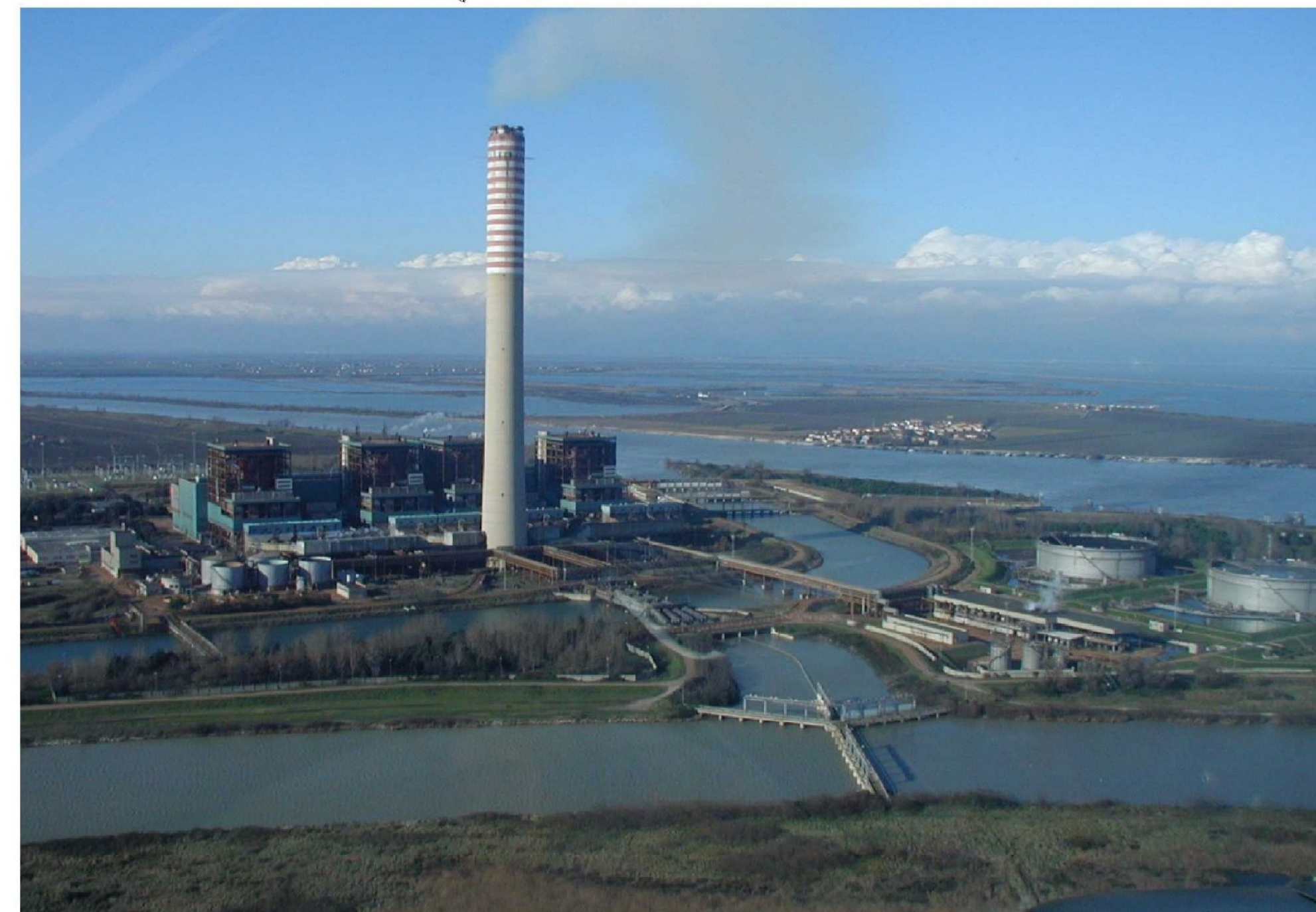
Vista complessiva della centrale da est
