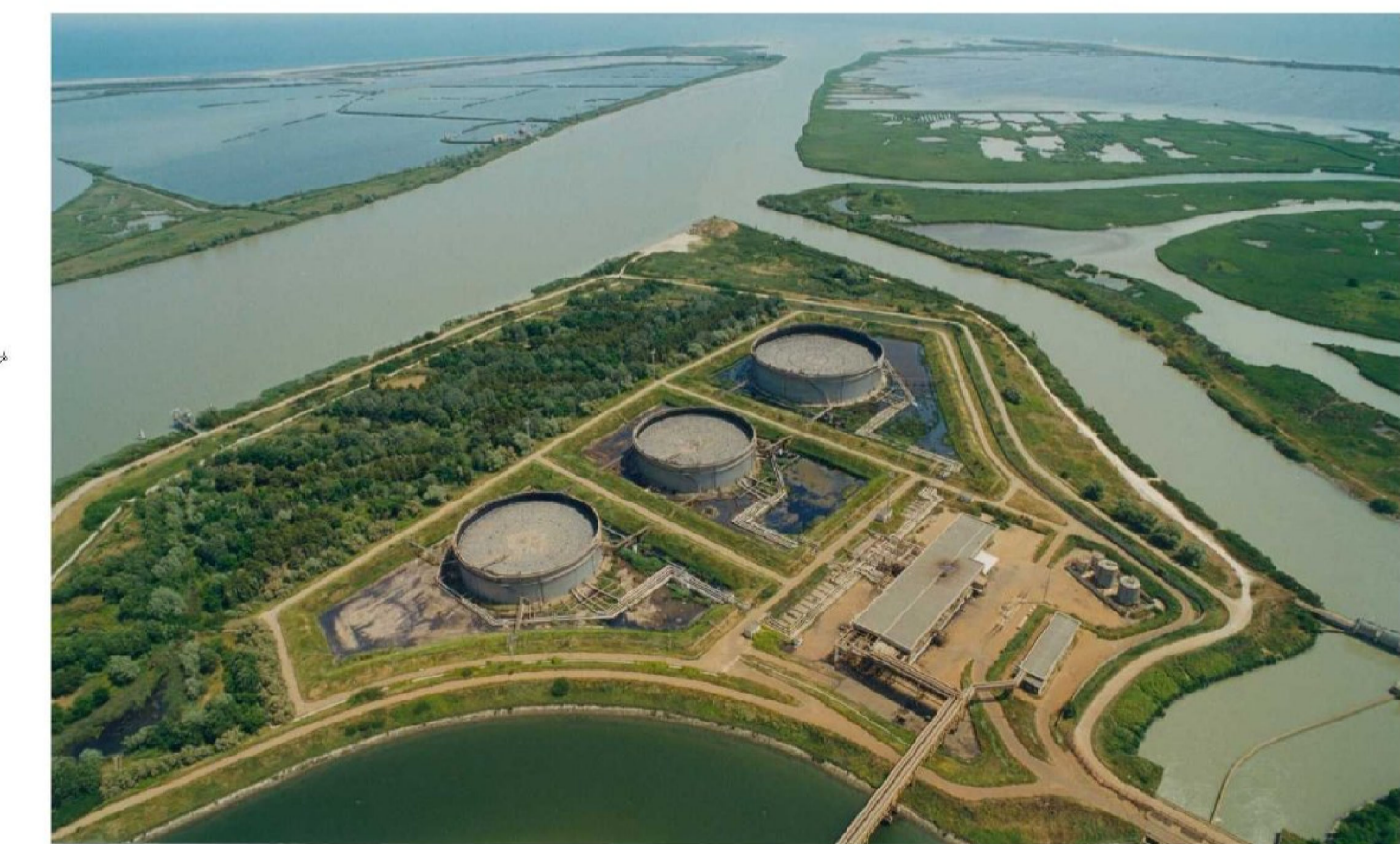
Parco Combustibili Nord e Canale di restituzione
