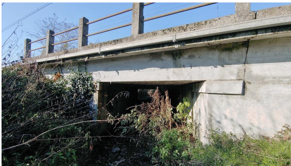
Figura 11-4 Stato attuale dell'attraversamento Cavo Maretto – prospetto Sud
