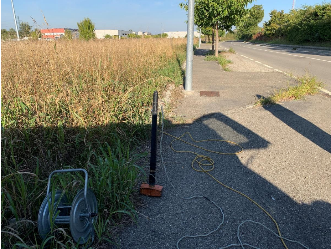
Figura 4.35: Foto relativa all'esecuzione della prova sismica MASW7.
