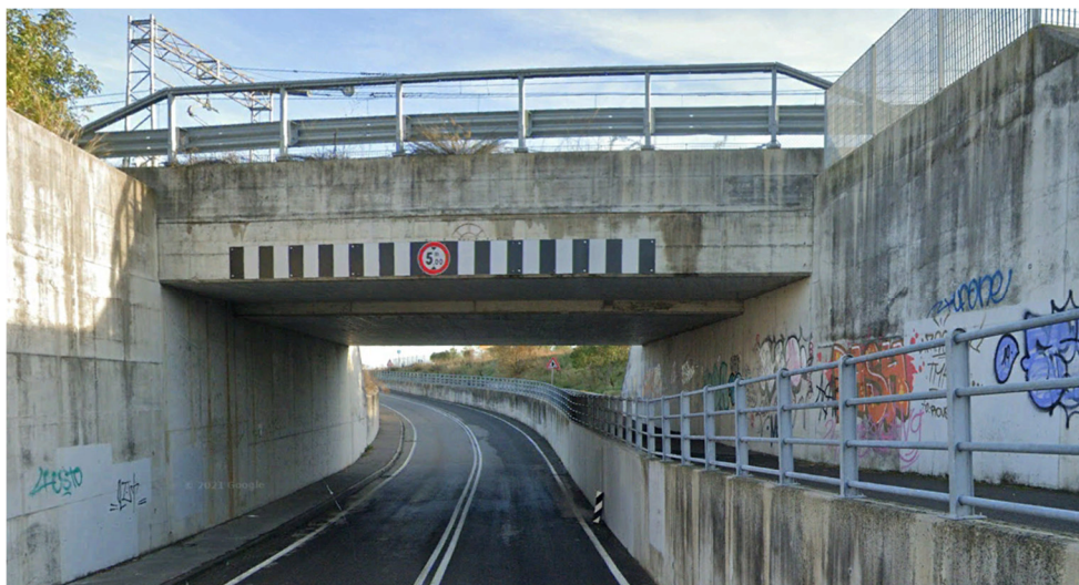
FIGURA 44: VISTA SCATOLARE ESISTENTE
