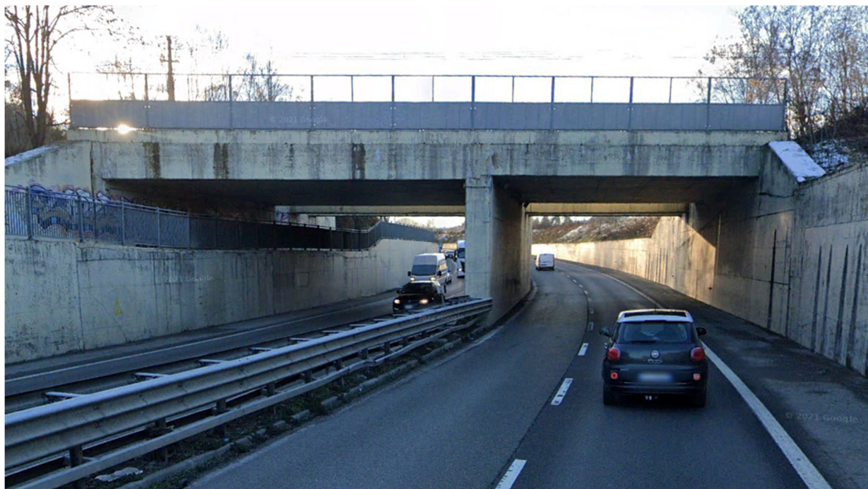
FIGURA 40: VISTA SCATOLARE ESISTENTE
