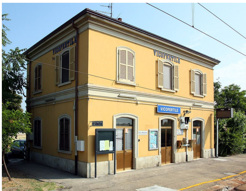
FIGURA 46: VISTA DEL FABBRICATO VIAGGIATORI DELLA STAZIONE DI VICOFERTILE
