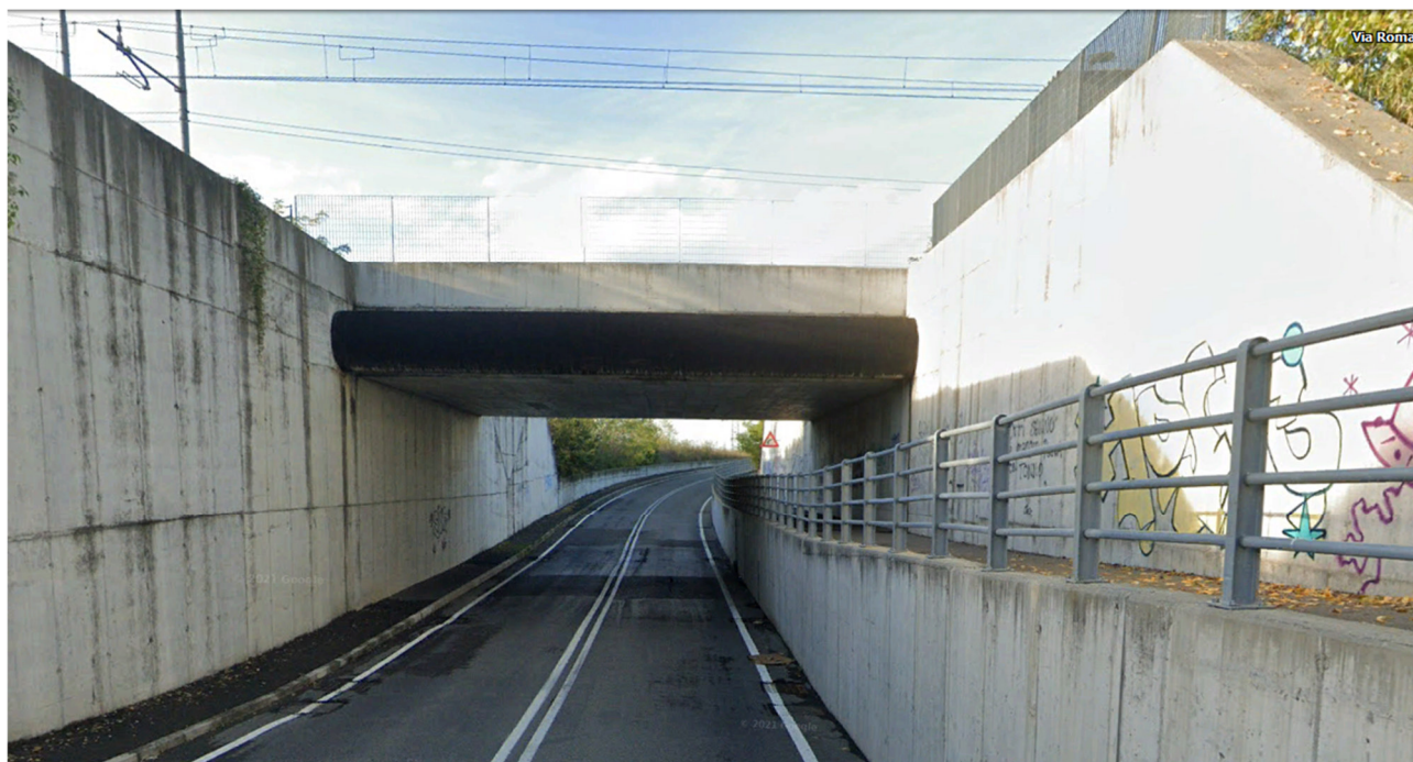
FIGURA 48: VISTA SCATOLARE ESISTENTE
