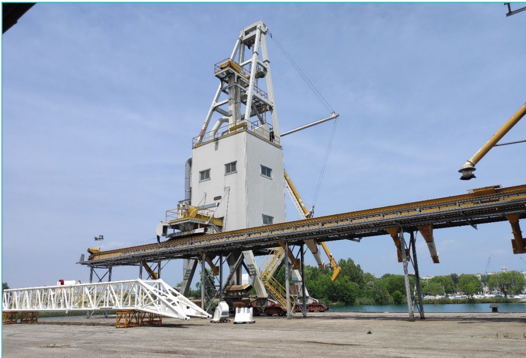
Figura 1.1: Foto dello stato attuale dell'impianto di movimentazione delle rinfuse solide
