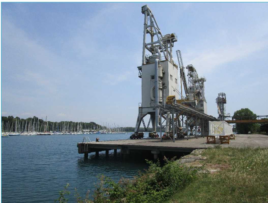
Figura 2.2: Foto dello stato attuale della banchina e di parte del retrostante piazzale
