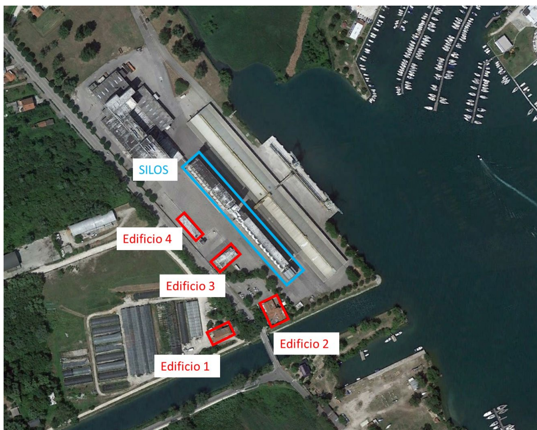
Figura 3-3: Edifici intorno all'impianto
