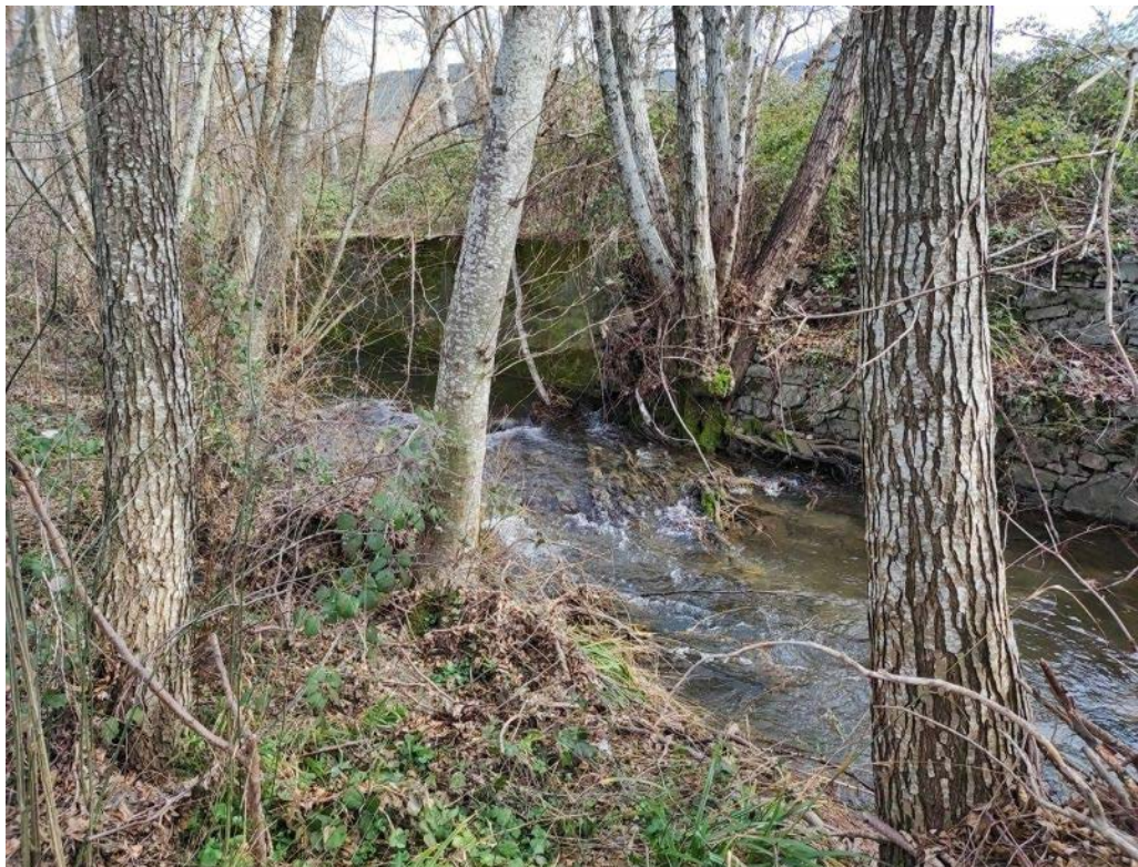
Figura 3-5 Foto ambito di attraversamento del corso d'acqua
