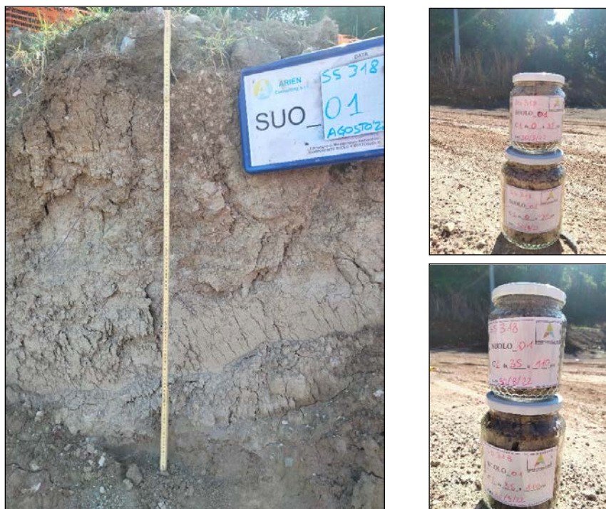
Particolare profilo e Campioni di suolo prelevati presso la stazione di monitoraggio suolo SUOLO_01. Area cantiere viadotto "Tre Vescovi" V campagna C.O.
