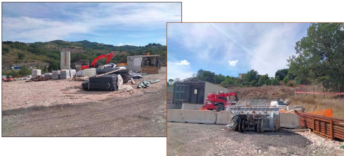
Particolare stazione di campionamento SUOLO_CB cantiere Base località Piano dell'Abate V C.O. agosto 2022
