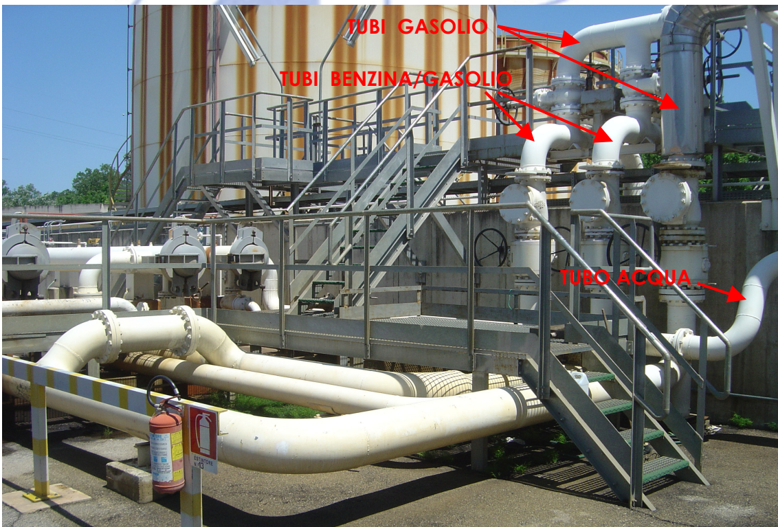
Dettaglio stazione di lancio/ricevimento pigs – manifolds di smistamento
