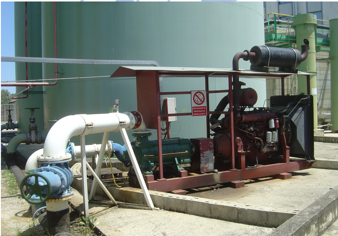
Deposito Abruzzo Costiero – motopompa acqua esistente
