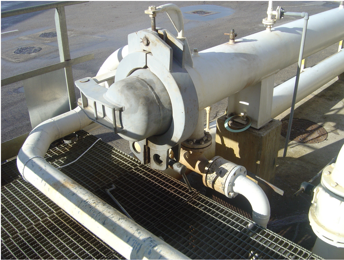
Dettaglio stazione di lancio/ricevimento pigs – trappole
