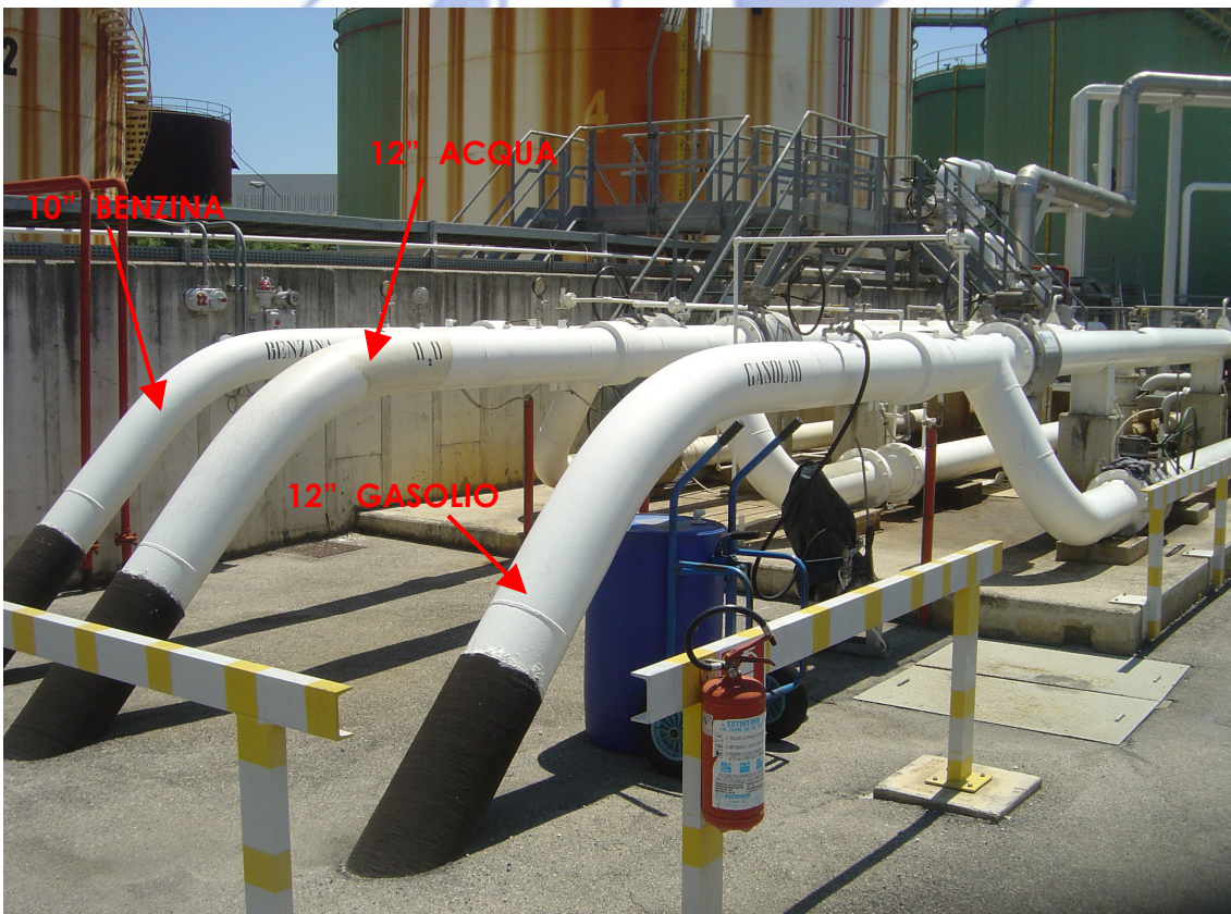
Dettaglio stazione di lancio/ricevimento pigs
