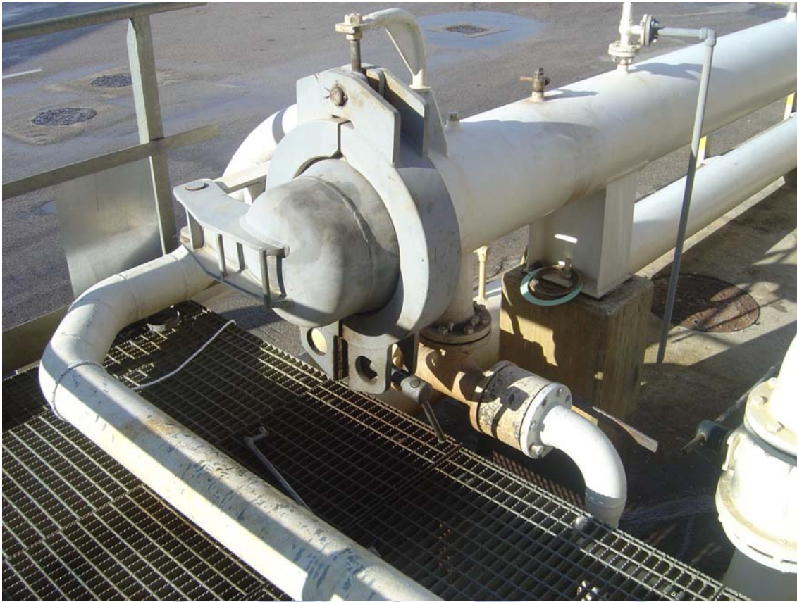
Dettaglio stazione di lancio/ricevimento pigs – trappole
