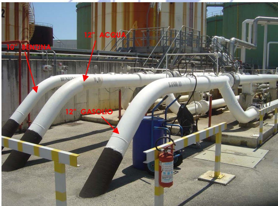
Dettaglio stazione di lancio/ricevimento pigs
