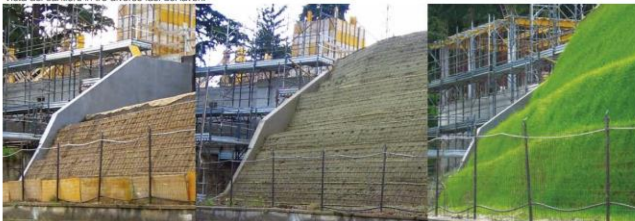
Figura 3: Fasi di esecuzione terre rinforzate
