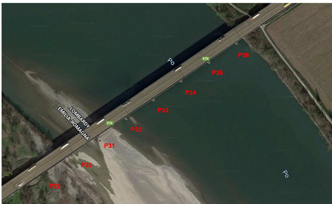
Figura 5 - Pile interessate da interventi di protezione da scalzamento
