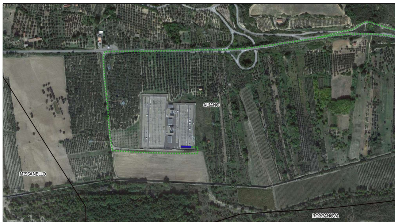
Figura 2.8.1: Individuazione su ortofoto dello stallo AT nella stazione Terna
