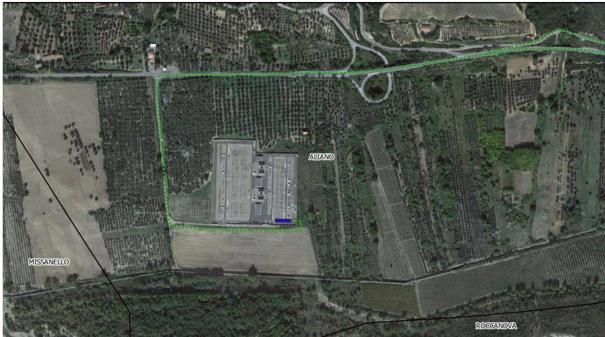
Figura 2.6.1: Individuazione su ortofoto dello stallo AT nella stazione Terna
