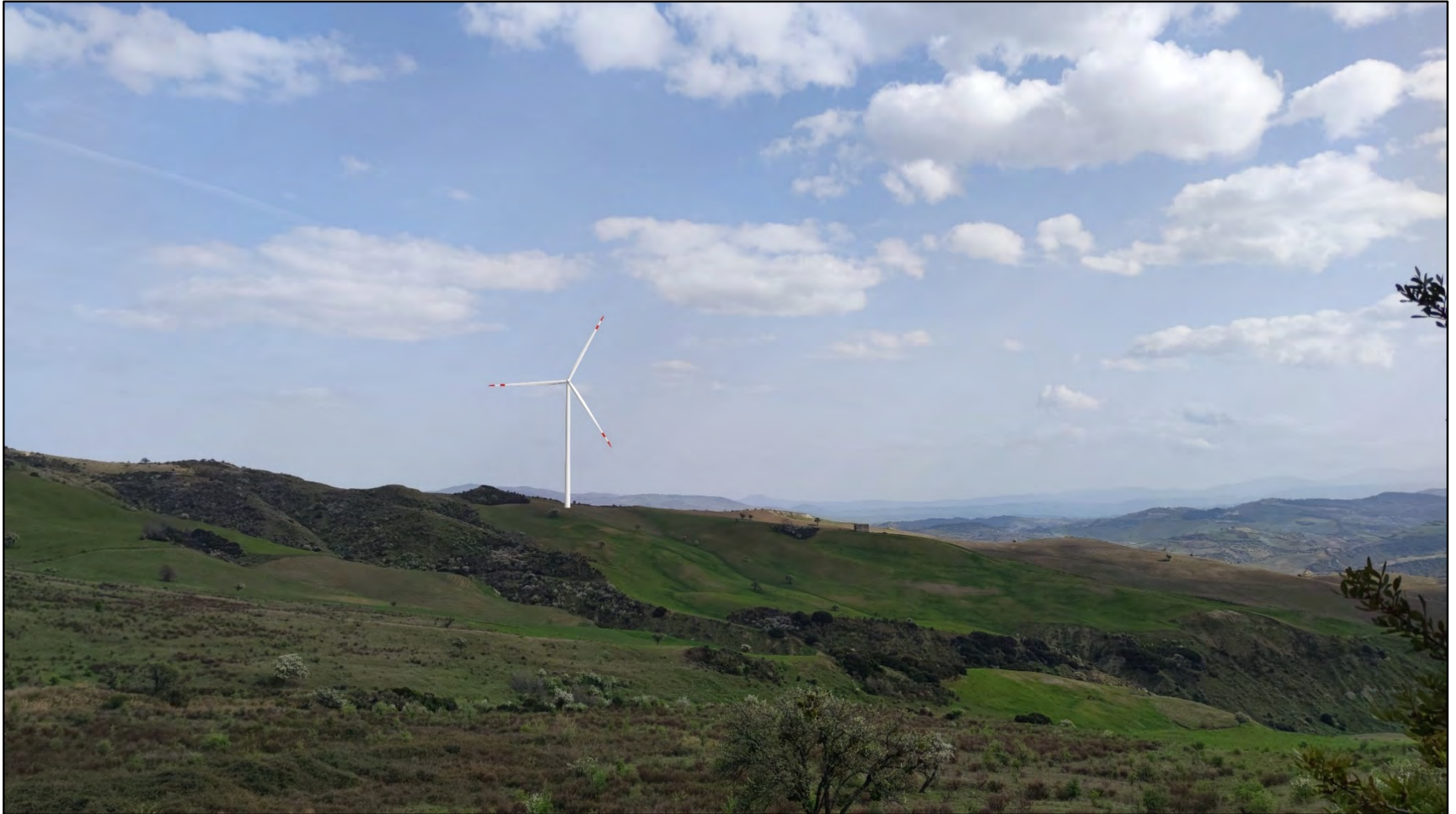
Foto 2: Punto di ripresa fotografica A – 40,293061^{\circ} 16,214502^{\circ} – Direzione Foto 132^{\circ} – Vista area WTG AL05 post operam
