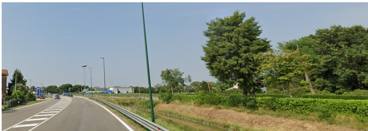
Figura 3-3 – margine carreggiata lato Collettore Acque Medie
