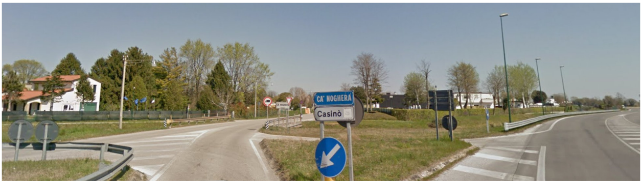
Figura 3-5 – vista dell'accesso per via Paliaga dalla SS14 al km 10+500
