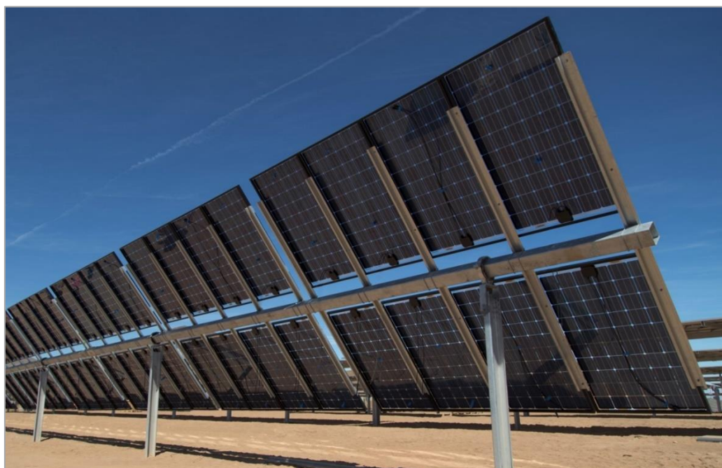
Figura.3- Esempio struttura + modulo FV bifacciale
