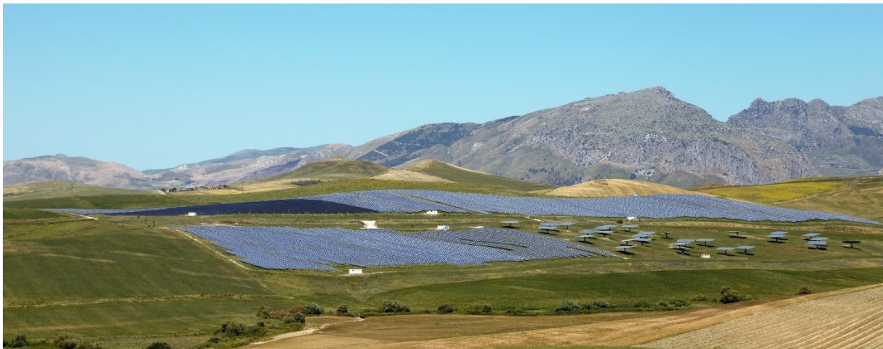
Figura 19 – parchi fotovoltaici presenti nei terreni limitrofi al sito di intervento
