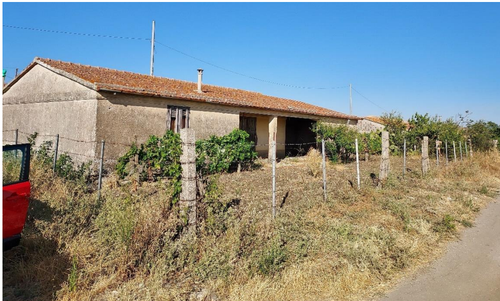
Figura 11 – Fabbricati nei pressi di Borgo Aquila
