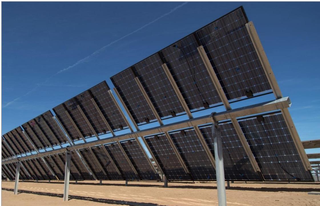
Figura III.3- Esempio struttura + modulo FV bifacciale
